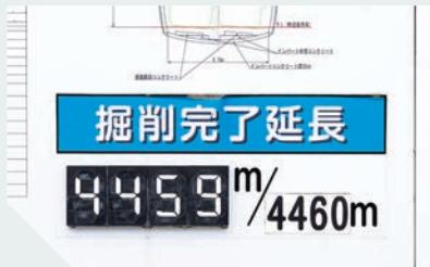
坑外の建屋前には掘削完了延長が表示され貫通当日の朝はいよいよ残り1mを表示
