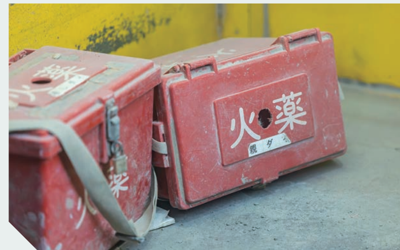
火薬を使うため安全は厳しく管理される これは発破後に残った火薬を回収・処理する箱で普段は点火場所に空の状態で保管されている
