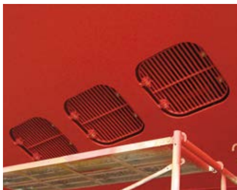
© 機関室の船底にあるシーチェストの開口
