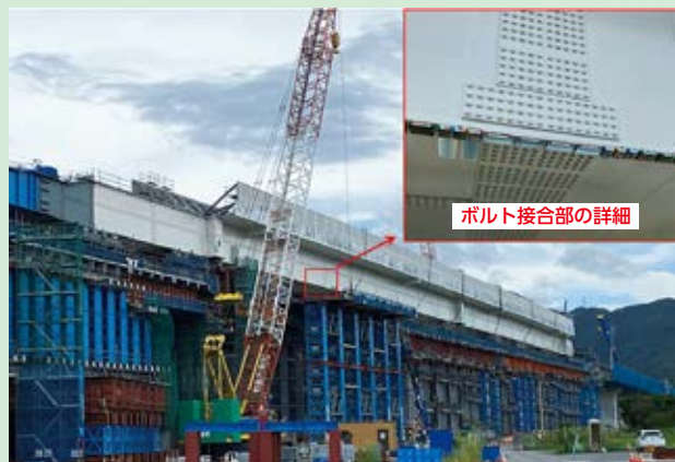
九州・北陸新幹線の建設において、F8Tのボルト施工では、既に本技術は適用しており、今後、強度の高いF10Tへの適用が可能となる技術
