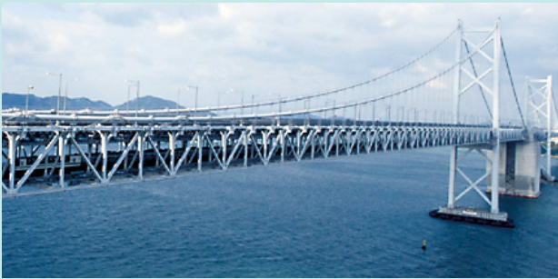
本四連絡橋（瀬戸大橋）
