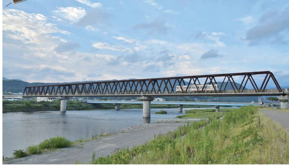
奈半利川に架かるトラス橋を走行する列車
