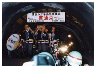
先進導坑貫通式
