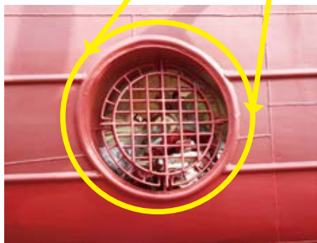
トンネル内部にプロペラがある。開口部の形状にも造船所のノウハウがある
