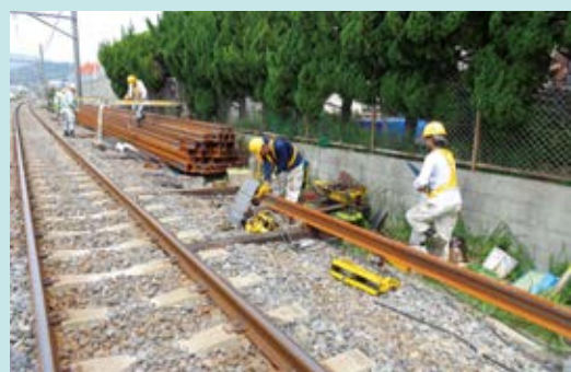
鉄道施設の修繕
