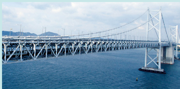
本四連絡橋（瀬戸大橋）
