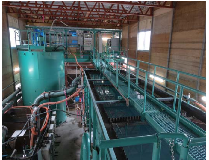
薬品等を使用して水のpH値などを処理・浄化する濁水処理施設
