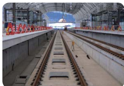
CLOSE UP ① 西九州新幹線のレールが1本につながりました。
