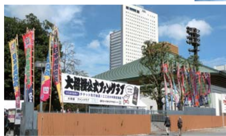
両国国技館全景
