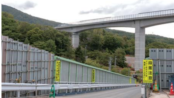
本線は後志自動車道の下をくぐる。作業路にはほぼすべて防音パネルが並べられている（石倉工区）
