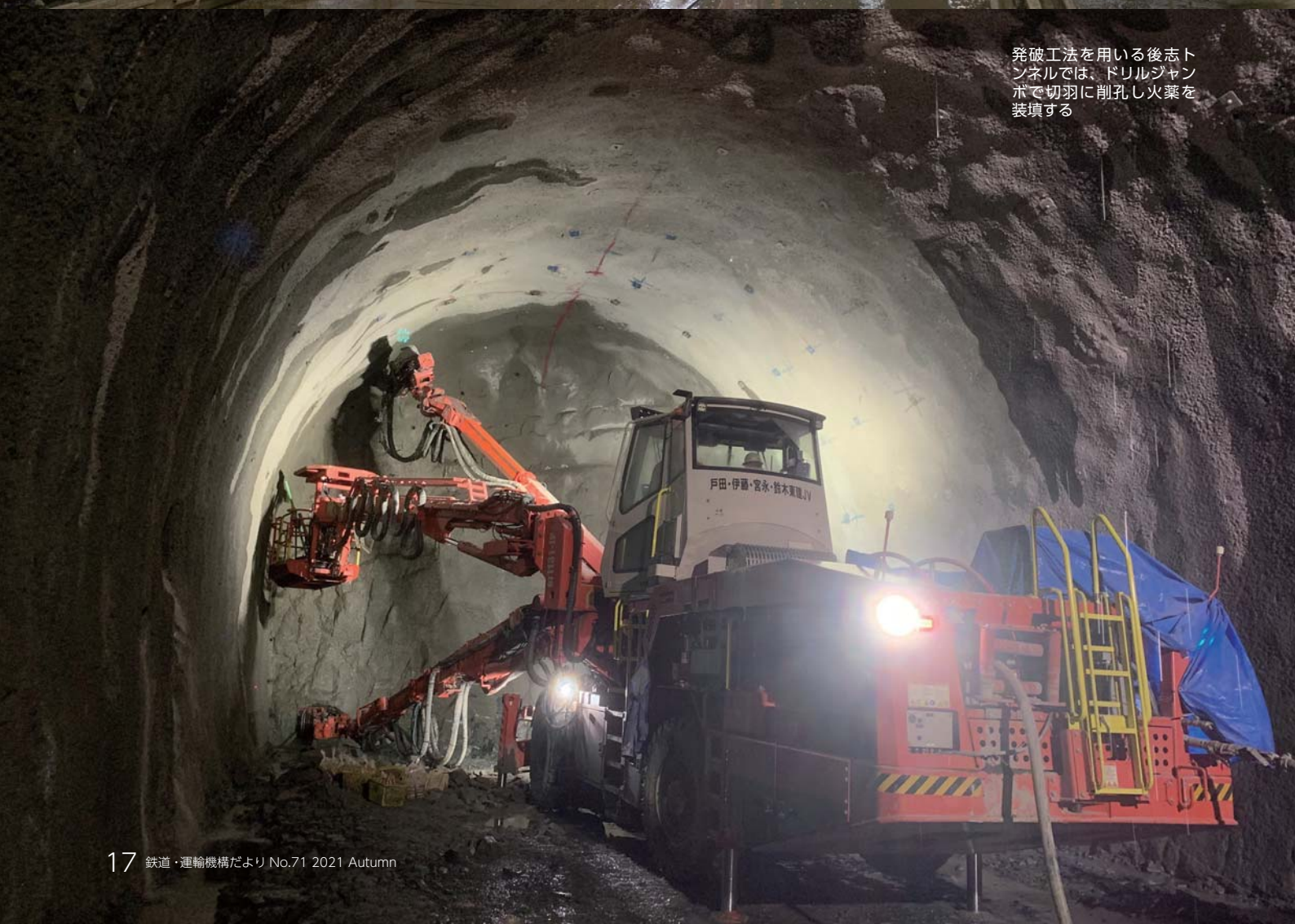
防水シート（手前の白い壁面）の張り付けに用いられる FILM 台車（塩谷工区）
