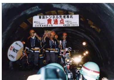
先進導坑貫通式
