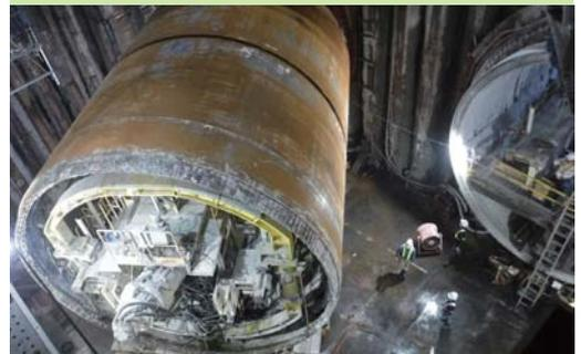
網島トンネル工事におけるシールドマシンのUターン (並列する単線トンネルを1つのシールドマシンで施工)
