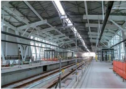
V字状の柱が特徴的な新大村駅のホーム。列車通過時の風圧を屋根の開口から逃がす。ホーム上への雨の吹き込みにも配慮した設計となっている
