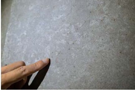
新横浜駅ホームの壁材にはリサイクル建材が使われている。茶色い粒は珈琲ガラだ
