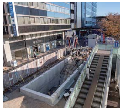
新横浜駅第4出入口。新横浜駅の浸水想定レベルである地上50cmまで土木躯体を構築し、その上に建物を建設する
