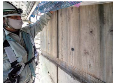
木の質感が見事に表現されたRC造の新綱島駅換気塔。土台部分も木目が写し込まれた部分も同じRC造だ
