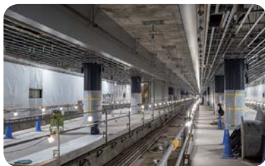
WORKING REPORT 東京支社 新横浜鉄道建築建設所
