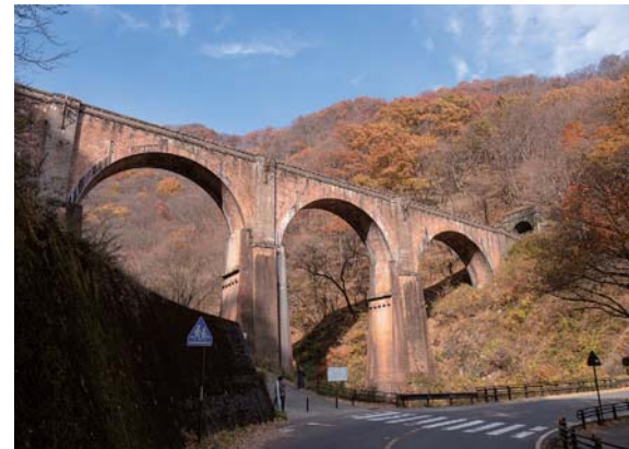
国の重要文化財に登録された旧信越本線碓氷第三橋りょう
