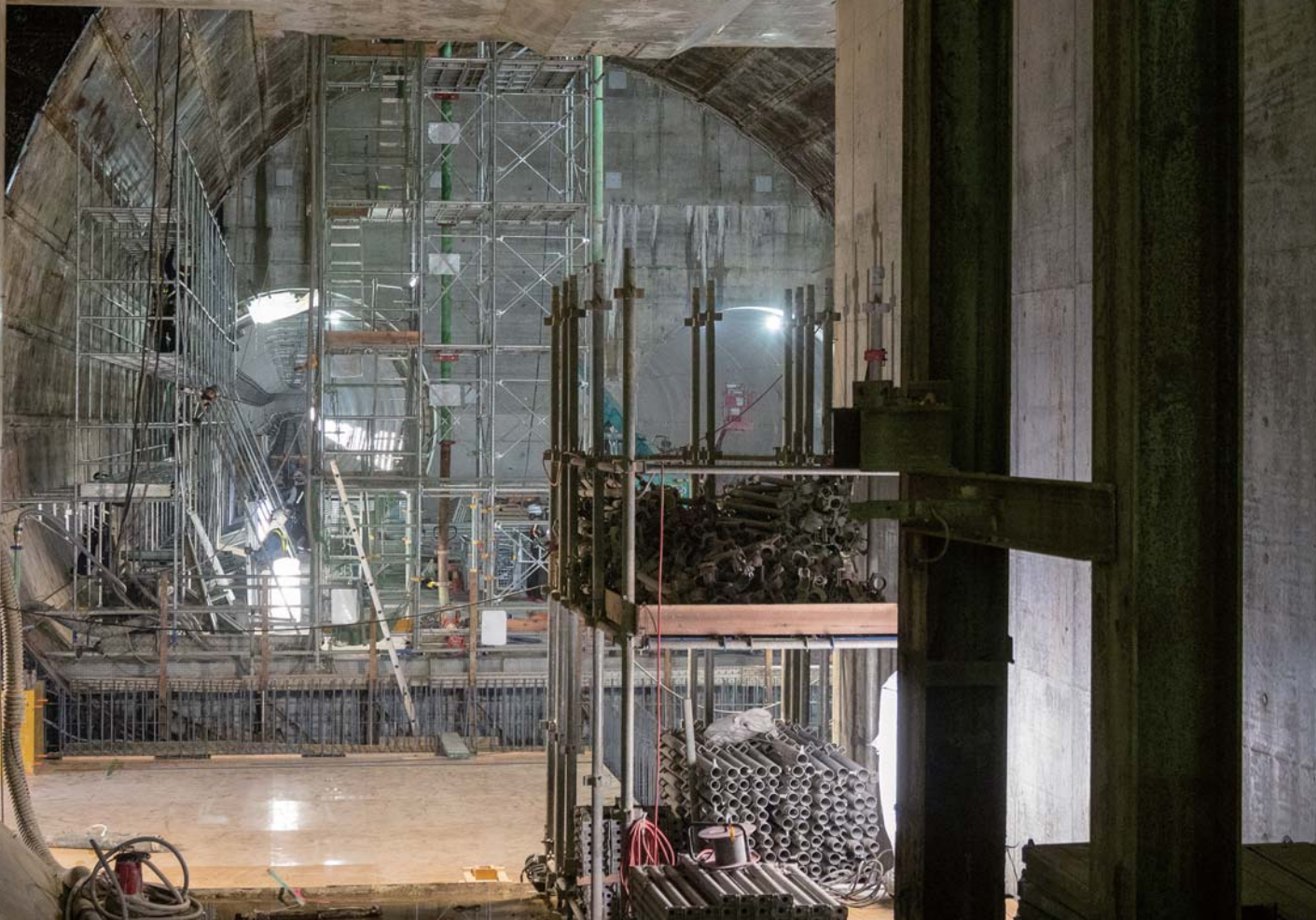
新綱島駅の終点方面では土木工事が進行中。延長 34.5 m の複線トンネルの先は、単線トンネル 2 つに分かれる
