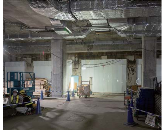
横浜市営地下鉄ブルーライン新横浜駅の躯体。既に開口部が設けられているが現時点では仮設壁で塞いでいる
