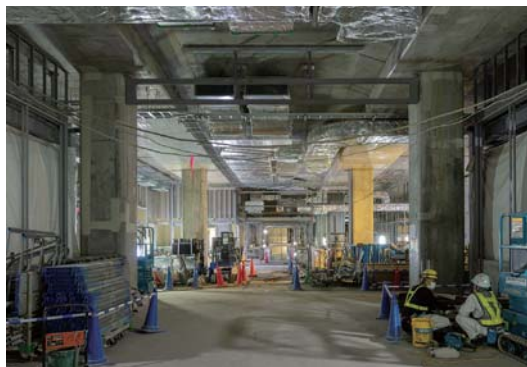
徐々に駅らしい姿になってきた新横浜駅羽沢方改札口。左右にホームへのエレベーターがあり、正面奥に地下2階への階段、その左右にエスカレーターがある
