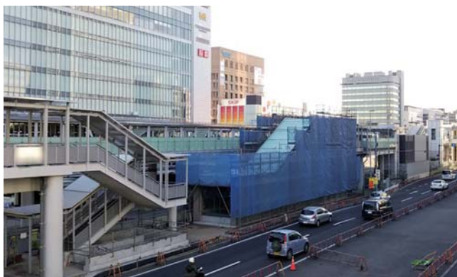
新横浜駅のペDESTリアンデッキに接続して出入口が建設されている。このため、ST線新横浜駅は地下駅にもかかわらず「地上2階地下4階」構造に
