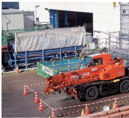
重機の後ろに仮設開口がある。大きさは5m×3mほどで決して大きくはない
