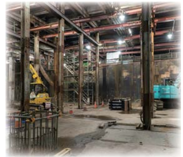
横浜市営地下鉄ブルーライン新横浜駅の躯体。既に開口部が設けられているが現時点では仮設壁で塞いでいる
