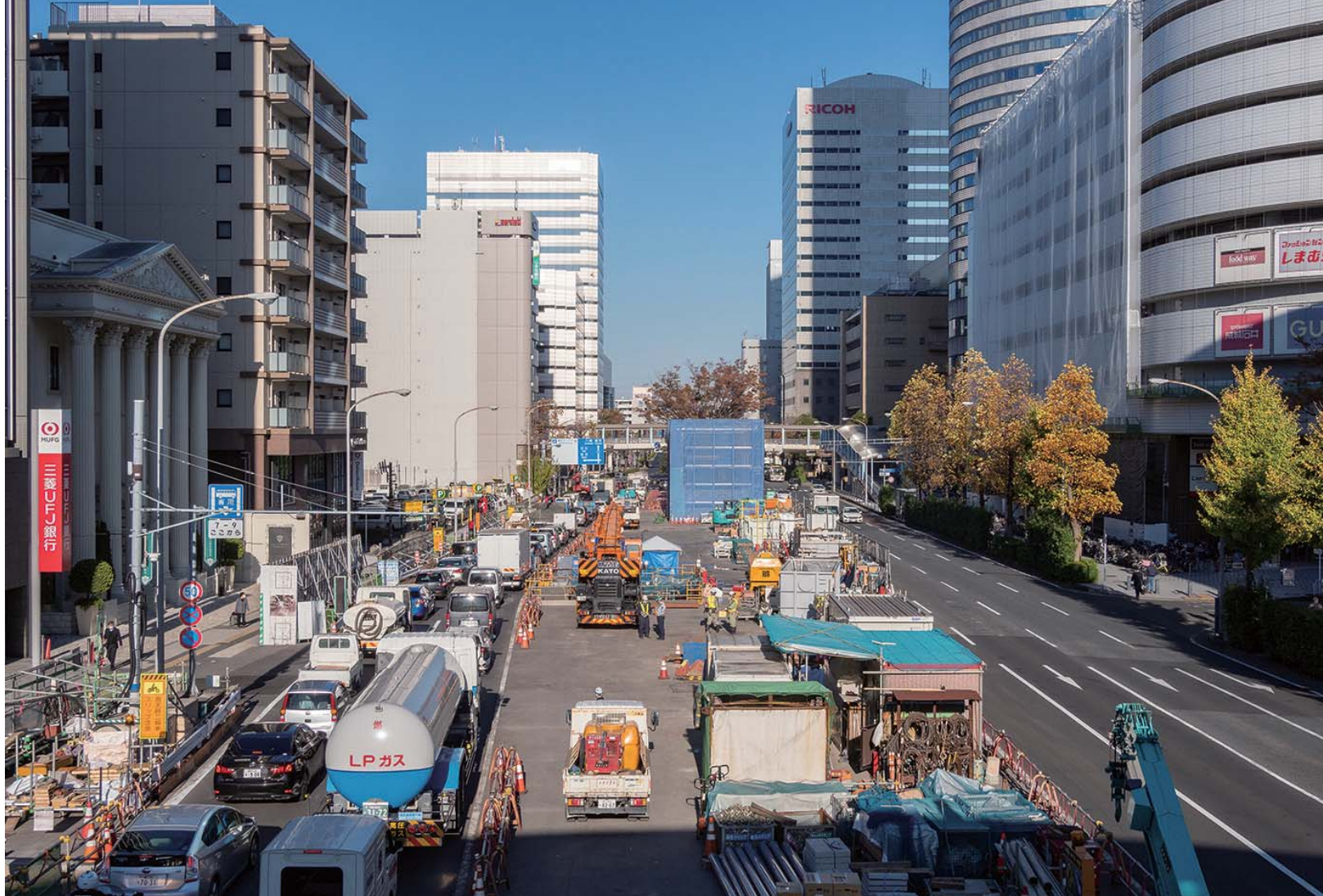
環状2号線直下で施工しており中央分離帯をヤードとして使用。前方の青いネットで覆われた部分は日吉駅方の換気塔
