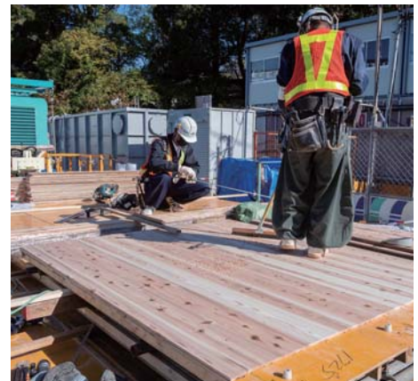
杉の天然木を型枠に貼り付けてコンクリートを流し込む
