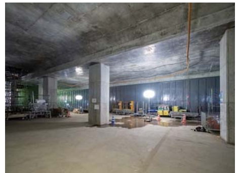
新綱島駅地下1階の改札口予定地。柱の手前に自動改札が設置され、奥がラッチ（改札）内。左に見える足場部分には地上からのエレベーターが設置される
