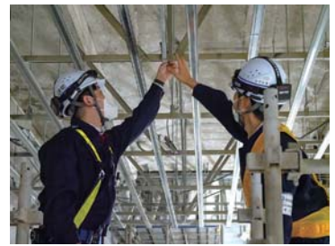
換気設備などの取り付けもほぼ終わり、ホーム上に天井材が準備された。アルミ製ながら木目調の温かみある天井材だ
