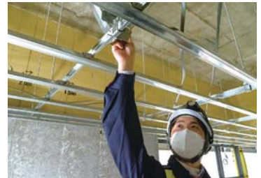
安全設備の確認は何よりも重要な職務だ。耐震性を向上させる耐震プレースが計画どおりしっかりと取り付けられているか確認する
