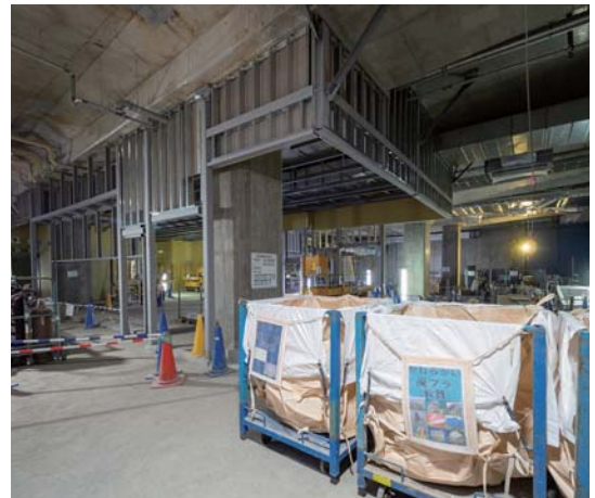
第1出入口から降りてきたところの改札口予定地。正面が有人改札窓口、左奥が自動券売機のスペースだ。狭い場所に多くの関係者が作業を行うため、コーンは「危険」、「資材置き場」など用途によって色分けされている。ゴミ類の分別もきめ細かい
