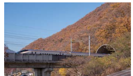
急速施工が実施された五里ヶ峯トンネル
