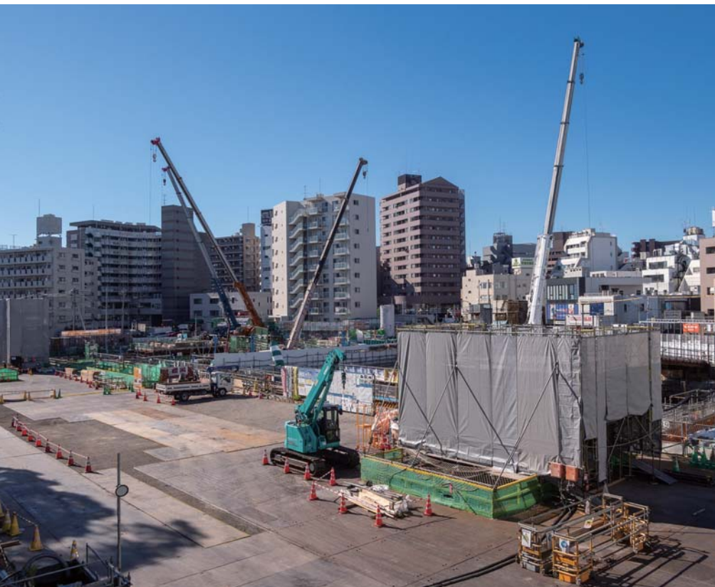
一見広そうに見える新綱島駅の工事ヤード。フェンスの向こうは、駅周辺の再開発工事が行われている
