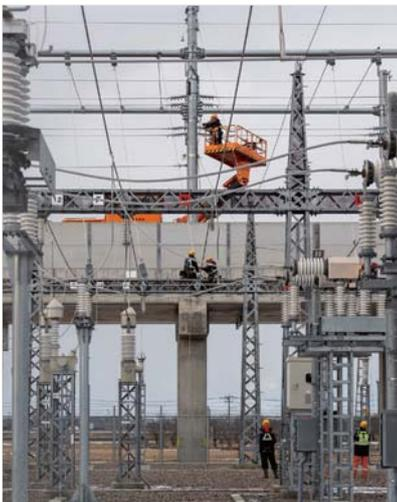
新加賀き電区分所へATき電線を接続する。新幹線の安定輸送に欠かせない設備だ
