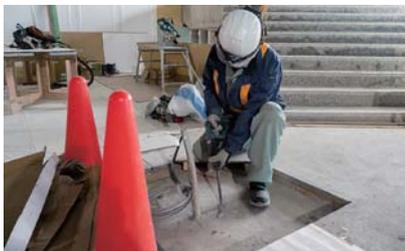
床下のケーブルを取める溝を作る。細部にわたるまで人の手でしっかりと作り上げていく
