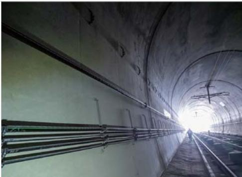
トンネルの壁面には各種ケーブルが設置されている。今後、電源ケーブルが上の金具位置に設置される
