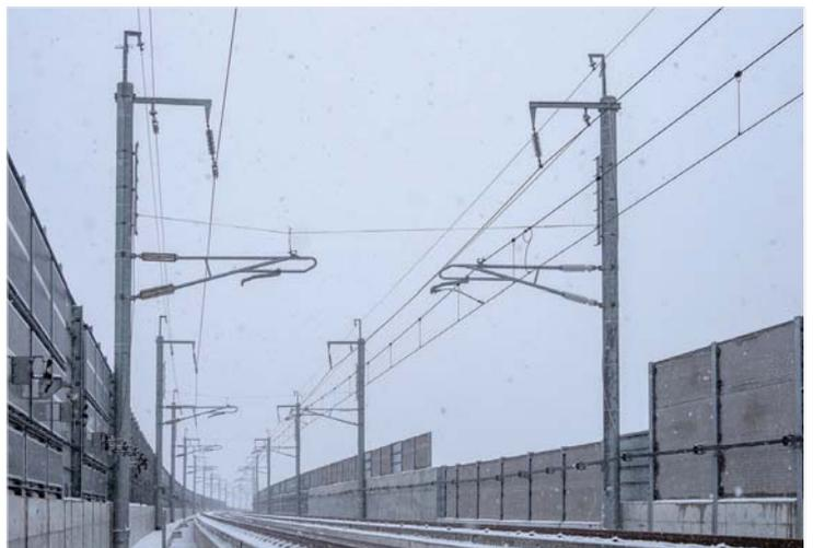
鋼管柱の中ほどから伸びる三角のアームが可動ブラケット。先端にちょう架線が取り付けられ、その下にパンタグラフと接するトロリ線がある
