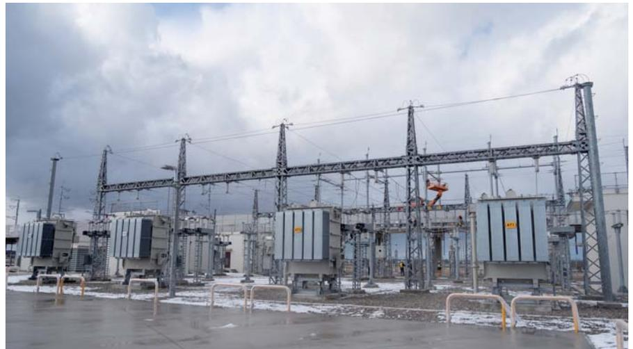
変電所からの電気が切り替わる地点にあり、巨大なスイッチの役割を果たす新加賀き電区分所
