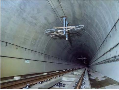
加賀トンネルの起点方坑口付近は下り線の軌道スラブ本設を待っている状態。時折資材を乗せたトロ（手押し運搬車）が仮軌道の上を通過していく
