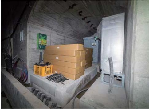
500mごとに設置されている器材坑。保守時の待避所にもなる。器材坑には沿線電話、トンネル内の電源供給用電源設備、信号ボックスなどが設置されている
