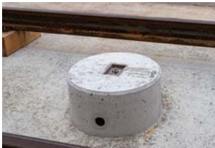
突起コンクリートの中央に見えるのが、軌道敷設のための基準器。雪によるケーブル損傷を防ぐため、ケーブル類を通す穴が設けられている
