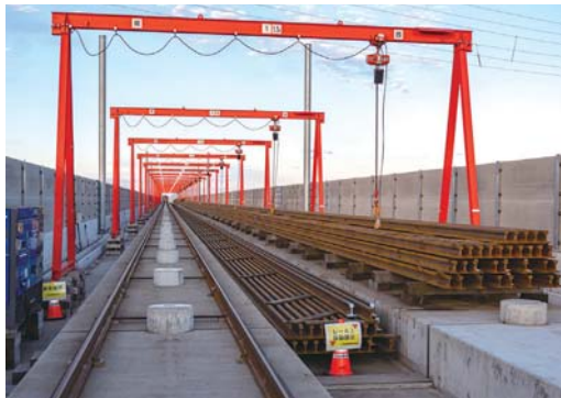
200 m長尺レール約 100 本を貯積している川北軌道基地。レールは固定式のテルハと呼ばれる装置 12 台で吊り上げる。レールは縦列で貯積されているためテルハは 24 台ある
