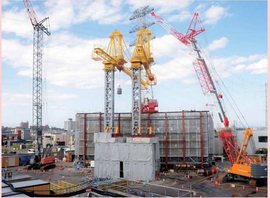
札幌市内で工事が進む、札幌トンネル(札幌工区)シールド発進立坑
