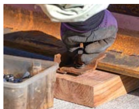
現段階では工事用の車両が使用する仮軌道であるため、レールは木製の台にボルトで固定する
