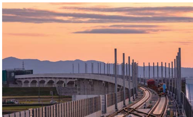
夕暮れ迫る川北軌道基地にレール運搬車が帰ってきた。仮軌道の敷設に続いて電化柱の建植も進んでいる。後方には手取川橋梁が見える
