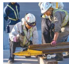
前方に送り出されたレールは、路盤から1m弱の高さがあるため、作業員たちによって徐々に路盤面まで降ろされる
