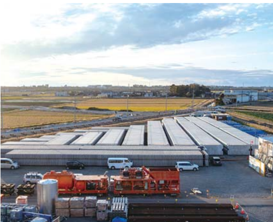
川北軌道基地のストックヤードに縦置きされた平板軌道スラブ。変形を避けるため縦置きにて保管されている。軌道スラブ製造工場は、長野・金沢間建設時と同じ設備を使用しているため石川県から離れており、必要に応じていつでも現場に供給できるよう約3,000枚がストックされている
