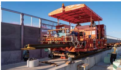
レールの先端には、「舟」と呼ばれる金具が取り付けられ、レールが施設を傷つけないよう養生されている
