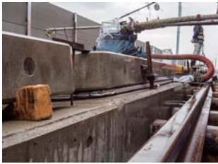
CAモルタル注入前（手前）と注入後（奥）。CAモルタルは温度管理も重要で、雨天時のほか冬季も原則として注入作業は行われない
