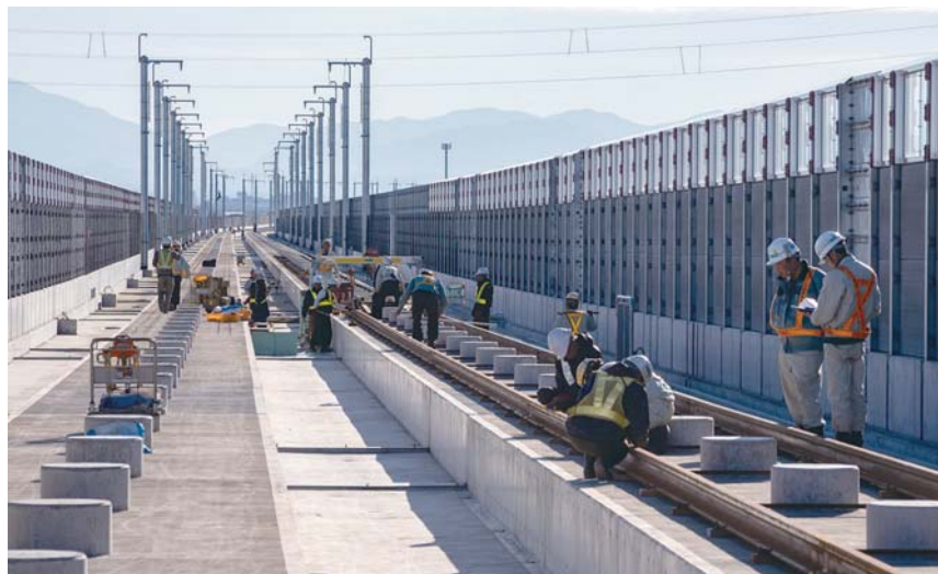
仮軌道の延伸を前に、午前中に敷設された軌道の検測を行う
