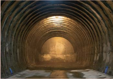
令和2年2月に掘削を完了し、昆布トンネル(宮田工区)の貫通を待つ昆布トンネル(桂台工区)終端部
