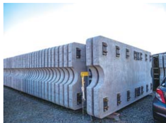
川北軌道基地のストックヤードに縦置きされた平板軌道スラブ。変形を避けるため縦置きにて保管されている。軌道スラブ製造工場は、長野・金沢間建設時と同じ設備を使用しているため石川県から離れており、必要に応じていつでも現場に供給できるよう約3,000枚がストックされている
