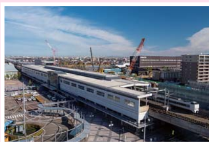
WORKING REPORT（大阪支社 小松鉄道軌道建設所）
