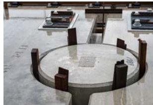
突起コンクリートの周囲には合成樹脂が注入される。前後の荷重はここで受け止める
