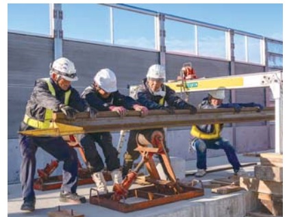
前方に送り出されたレールは、路盤から1m弱の高さがあるため、作業員たちによって徐々に路盤面まで降ろされる
