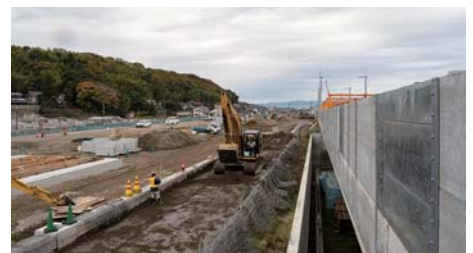
加賀温泉駅西側に建設中の保守車両基地。除雪車や確認車、保守用のモーターカーなどの基地となる
