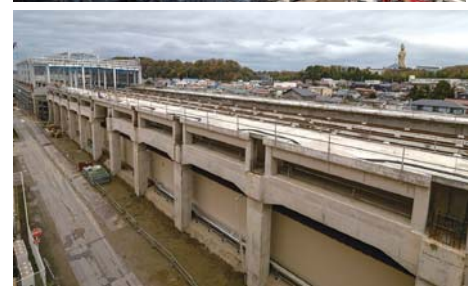
2018年11月に撮影した加賀温泉駅付近（「鉄道・運輸機構だより」2019年新春号より）（上）と2020年11月に同じ場所から撮影した加賀温泉駅。ホームが姿を現し、仮軌道が敷設されている
