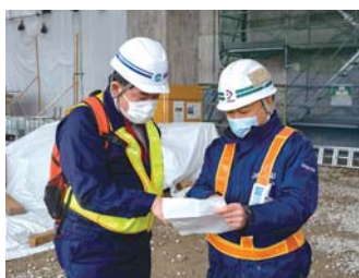
現場責任者と作業の進め方を確認する増田所長（左）。月一度、全受注者を含めた安全パトロールも行われている
