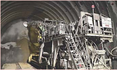
令和2年3月、隣接する渡島トンネル(台場山工区)に渡島トンネル(村山工区)が到達した瞬間
