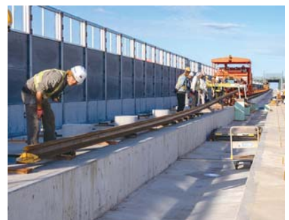
路盤面までレールが降ろされると、ボールなどで進路を微調整しながら200mまで伸ばしていく
