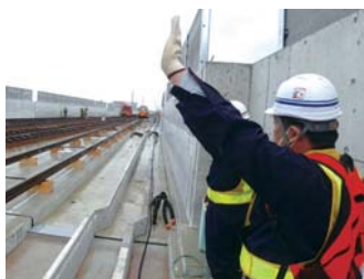
作業用車両が通過する時は手を上げて安全を確認
