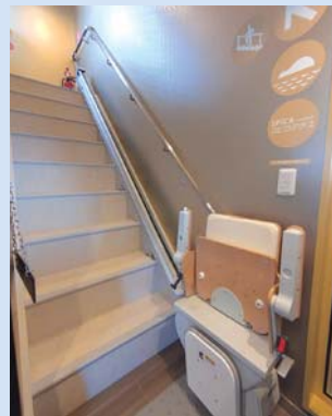
椅子式階段昇降設備
