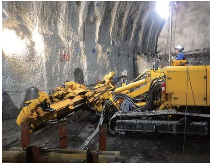
切羽の周辺部から前方の地質を確認する先進調査ボーリング作業
