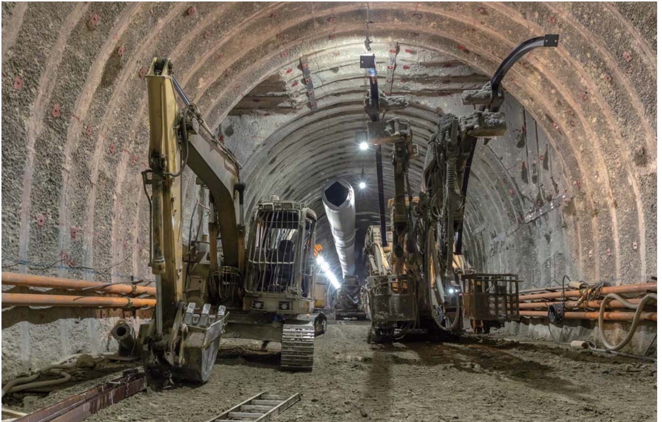
切羽後方では発破によって崩したズリを搬出するパワーショベル（左）と、鋼製支保工建て込み機（右）が控えている（朝里工区）
