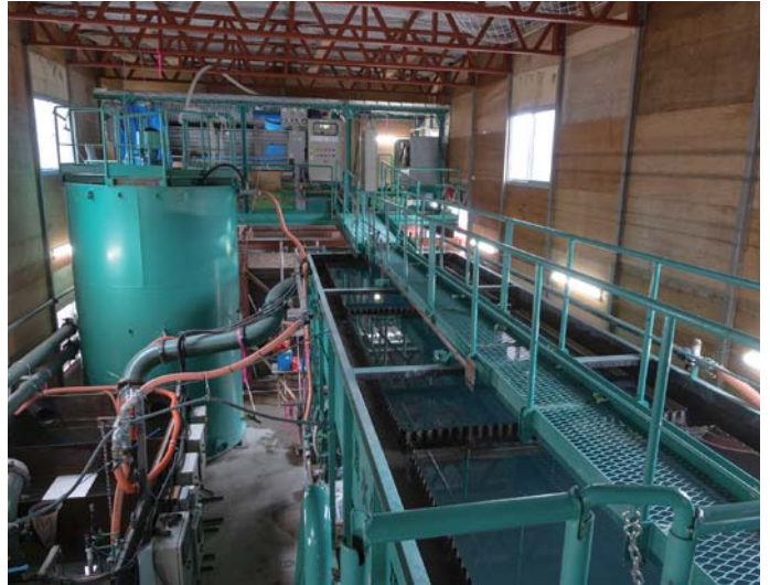
薬品等を使用して水のpH値などを処理・浄化する濁水処理施設
