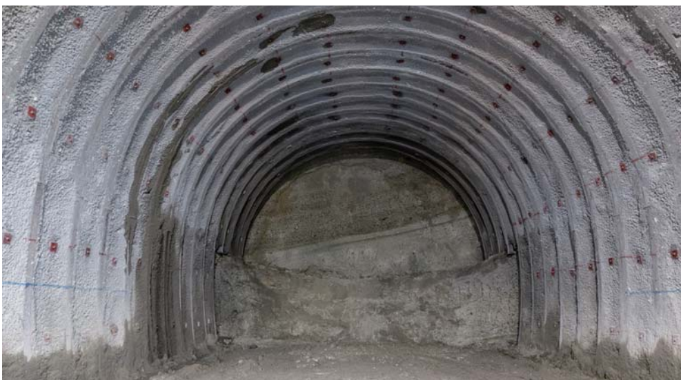
地層が露出している朝里トンネルの切羽。等間隔で鋼製支保工が建て込まれており、赤く塗られたロックボルトも見える
