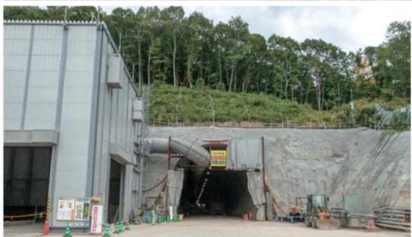
一見小さく見える札幌トンネル石倉工区の本坑。周辺に民家があるので、坑外の施設は防音ピット（左）に覆われている
