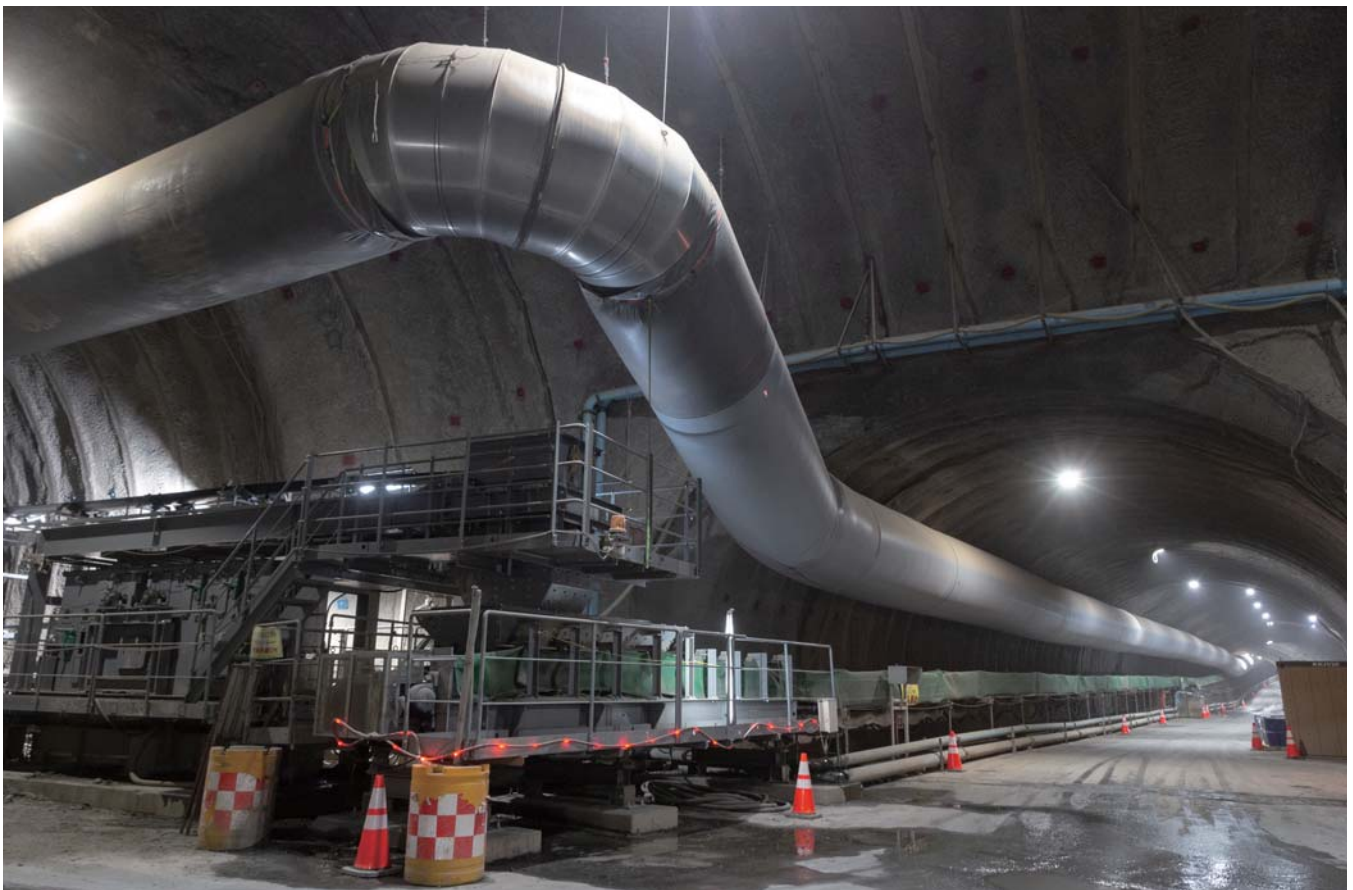
土被りが最大550 mの後志トンネル塩谷工区では本坑までの斜坑も長い。手前が本坑、奥に伸びるトンネルが斜坑だ
