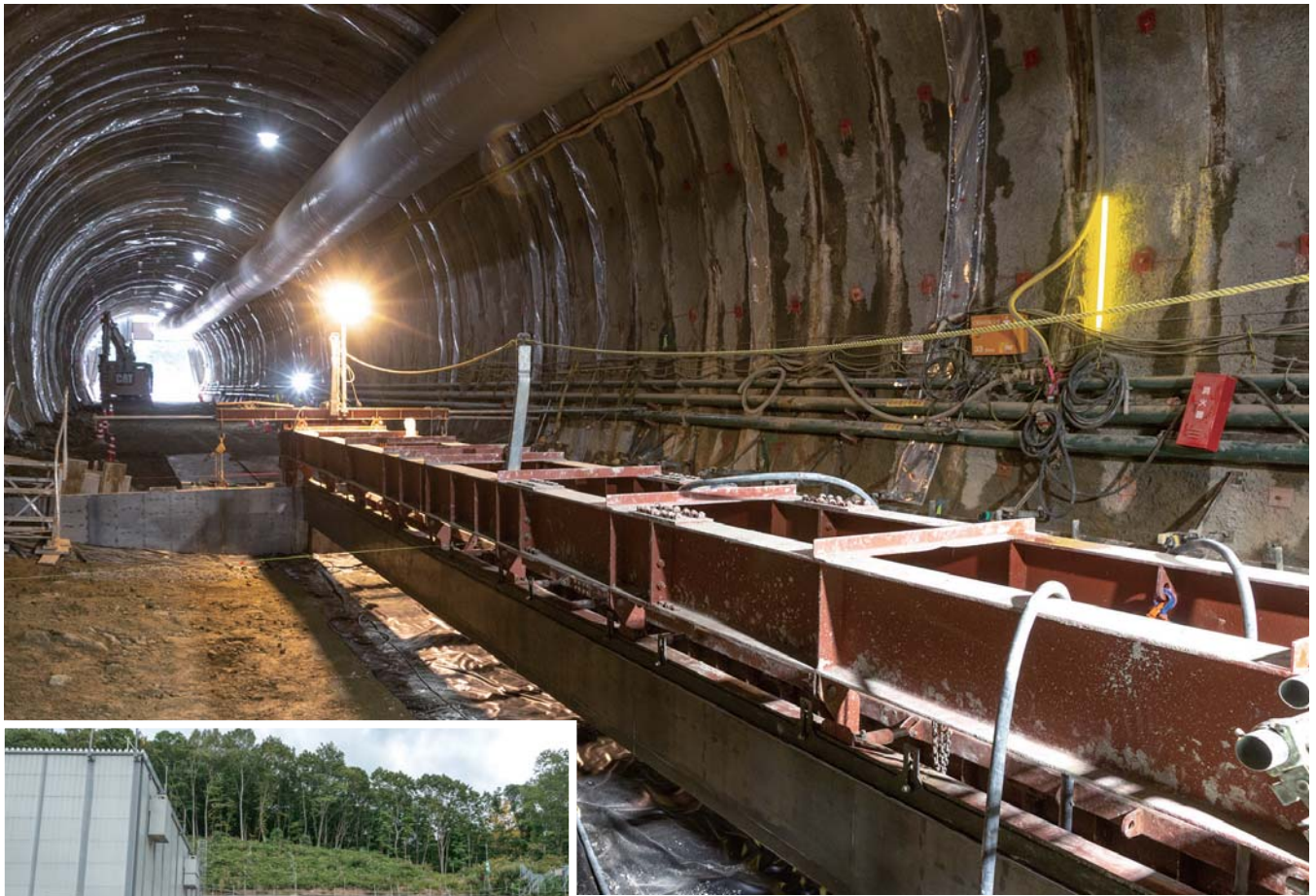
トンネル内部では、アーチ状のトンネル断面を支えるために床面へ逆アーチ状の形をしたインバートコンクリートを打設する（石倉工区）
