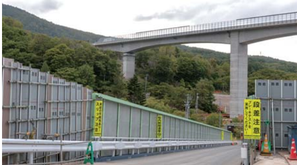
本線は後志自動車道の下をくぐる。作業路にはほぼすべて防音パネルが並べられている（石倉工区）
