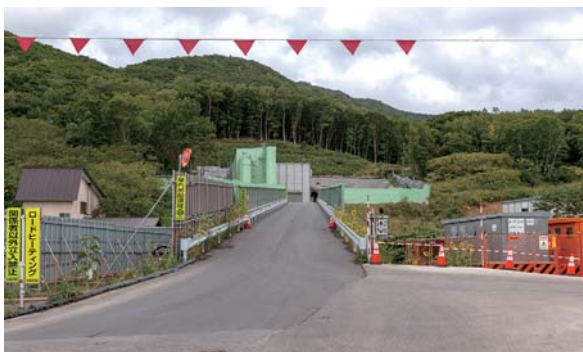
札幌トンネルの坑口の手前には川があり仮橋を設けて施工している。民家も近いので防音等には細心の注意が払われている（石倉工区）
