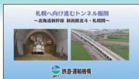
■ 札幌へ向け進むトンネル掘削
