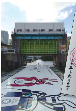
浜離宮前水門の水門をくぐる。水門の迫力が感じられます
