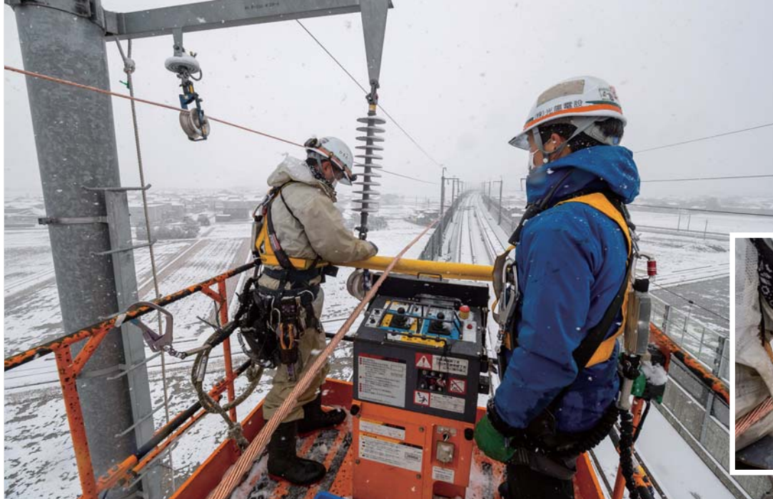
高所での作業となるため、フックをしっかりと手すりに取り付けて作業を行う
