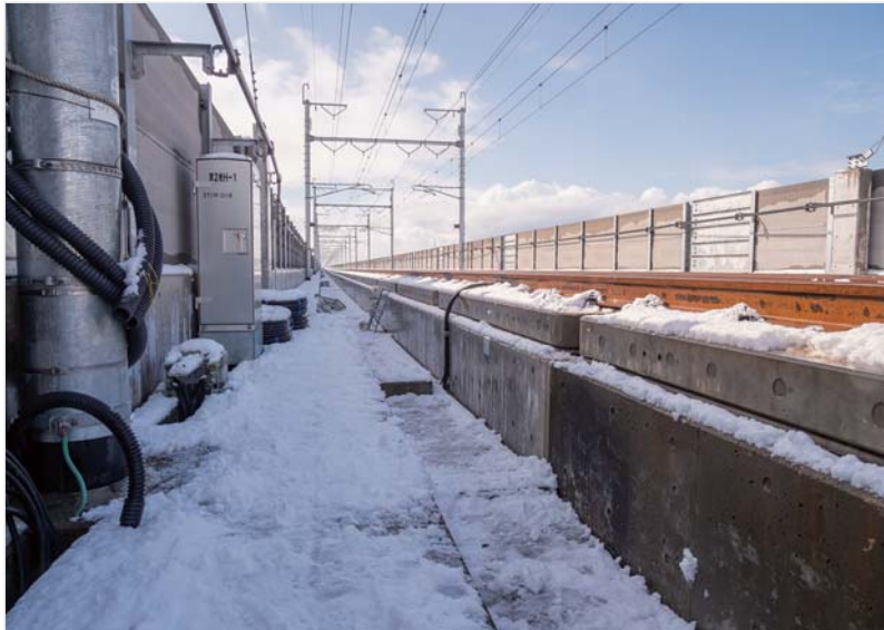
高崎起点356.48kmの地点にある既設線と新設線の境界。コンクリートの色が異なる
