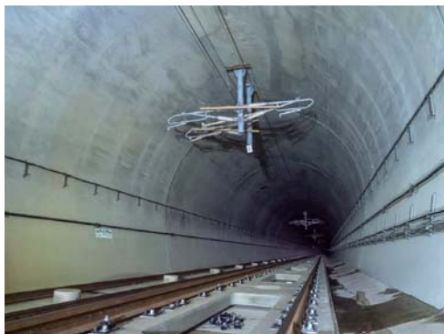
加賀トンネルの起点方坑口付近は下り線の軌道スラブ本設を待っている状態。時折資材を乗せたトロ（手押しの運搬車）が仮軌道の上を通過していく
