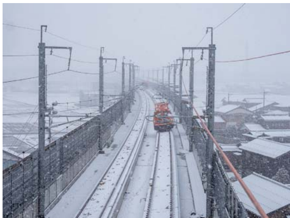
後方で別の架線作業車が待機中。雪は降っているが風が穏やかなので安全に作業が可能だ
