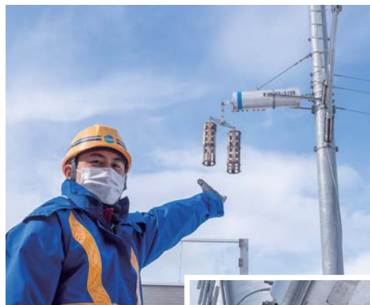
鉄道・運輸機構、鉄道総合技術研究所、メーカーが共同で特許を取得したテンションバランスの取り付け部材。取り付け部材が蝶番のような構造になっていて電車線の張力を維持しつつ揺れによる負荷は逃がす
