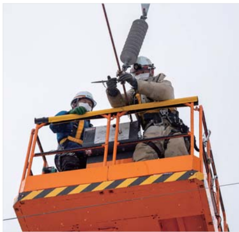
冬季で分厚い手袋を着用しているうえ、高所での取り付け作業のため、高い技術が求められる
