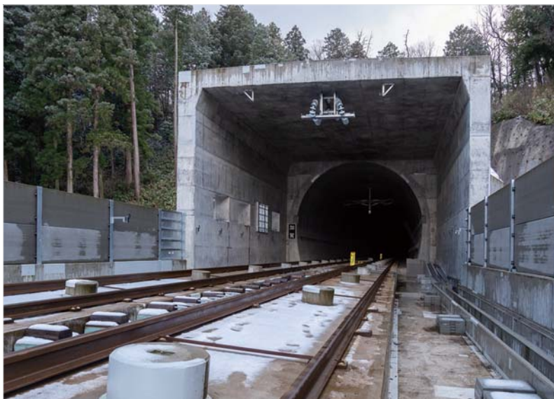
石川・福井県境に跨る加賀トンネル
