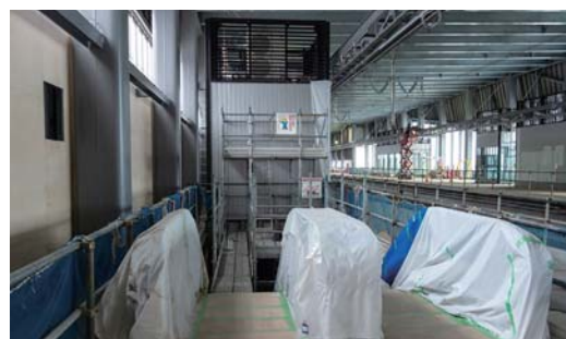
エスカレーターも設置され完成に近づいている
