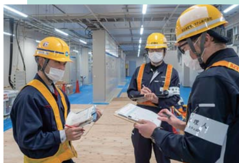
通信テストについて工事受注者の担当者と打ち合わせを行う。若手と言えども肩にかかる責任は大きい
