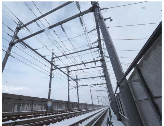
ここより先が既設線で、通電している
