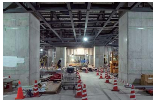
小松駅の構内コンコース。天井も立体的・多面的な造形となっている
