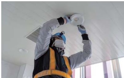
金沢駅などの工事も手がけたベテラン作業員が待合室の照明を丁寧に取り付け
