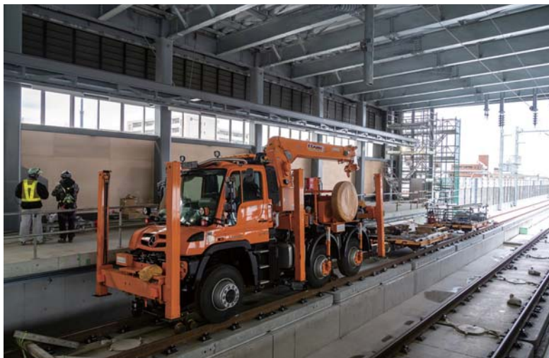
鋼管柱の建植などに使われる工事用機械。ドイツ製の車両を改造したものを購入して使用している
