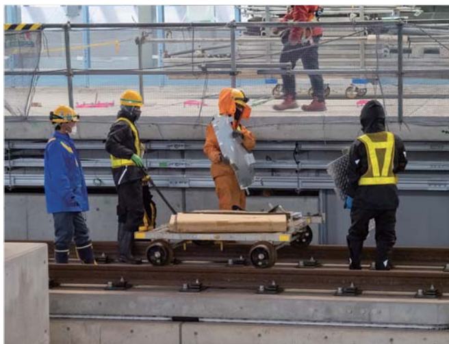
レール脇のケーブルダクトの湾曲部に取り付けられるスチール製のカバーを一つひとつ設置していく
