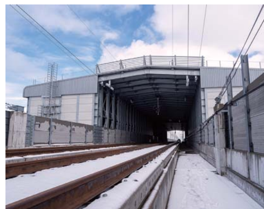
大型のスノーシェッドに守られた川北除雪基地。本誌68号の「ワーキングレポート」で紹介した仮軌道の敷設作業が行われていたのと同じ地点だ
