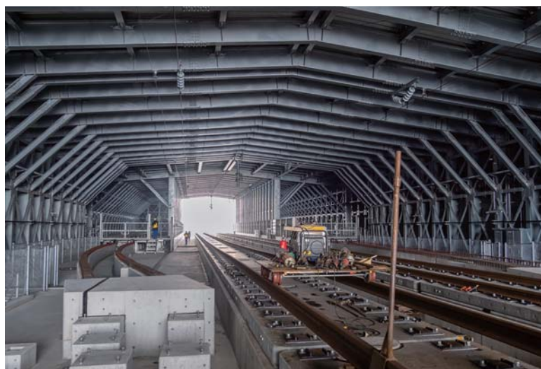
雪に強い北陸新幹線の要となる川北除雪基地。左側に除雪作業車の留置線が設置される
