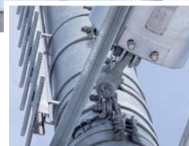
鉄道・運輸機構、鉄道総合技術研究所、メーカーが共同で特許を取得したテンションバランスの取り付け部材。取り付け部材が蝶番のような構造になっていて電車線の張力を維持しつつ揺れによる負荷は逃がす
