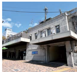
湊川駅の外観。駅舎は昭和3年開業当時のものが今も使われている
