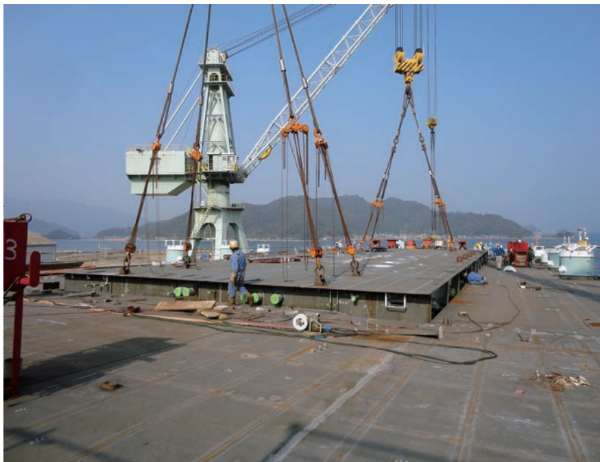
車両甲板ブロックの搭載。ブロックの前後を2台のクレーンで吊って慎重に定位位置に納めていく
