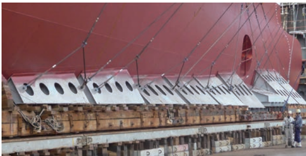
進水準備が整った進水台の船首付近。進水中に船体が傾かないよう、船首と船尾には仮支構（ボペット）が設けられる
