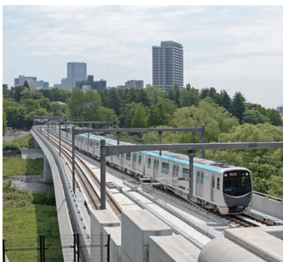
仙台市地下鉄 東西線（平成 27 年 12 月開業） 地下高速鉄道整備事業費補助（写真提供：仙台市）
