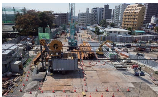
神奈川東部方面線（相鉄・東急直通線）「建設が進む新綱島駅（仮称）構築状況」
