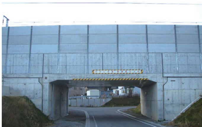
中学校線架道橋
