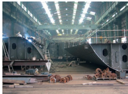
工場建屋内で平行して組み立て中のブロック群
