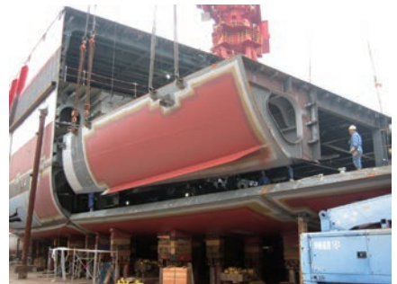
船台に搭載中のブロック。船体中央部付近の船底近くの部分である
