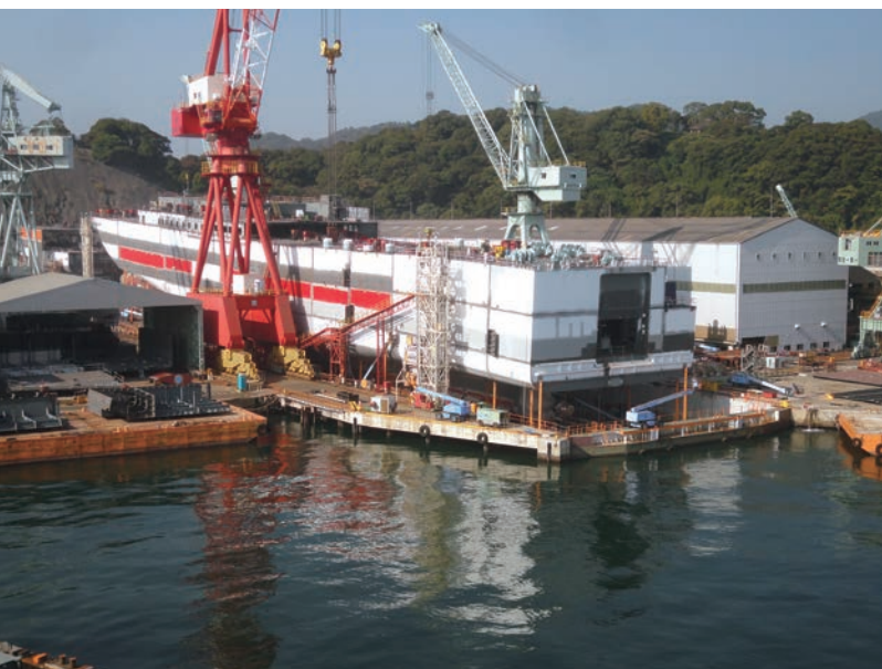
「フェリーしまんと」の前方に小さく見えるのが、タンデム搭載された3番船「フェリーどうご」の機関室付近のブロック
