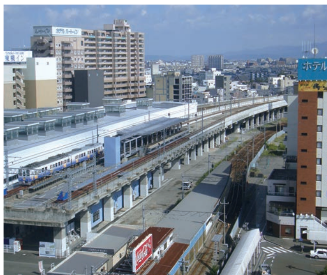
えちぜん鉄道線「仮線工事完了後の福井駅付近」
