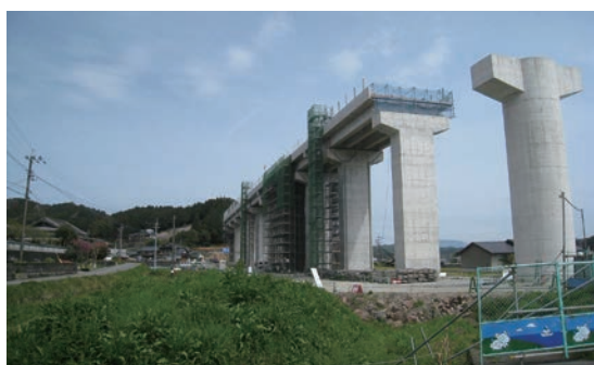
九州新幹線（武雄温泉・長崎間）「建設が進む袴野橋りょう他工区」
