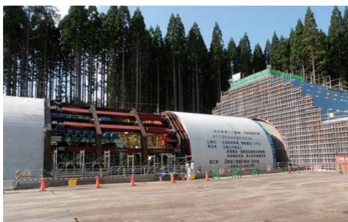
津軽蓬田トンネル
