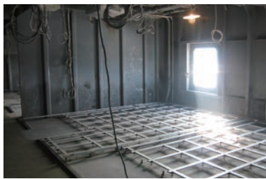
艀装中（内装）の客室部分。床や壁を張るための根太を取り付けているところ
