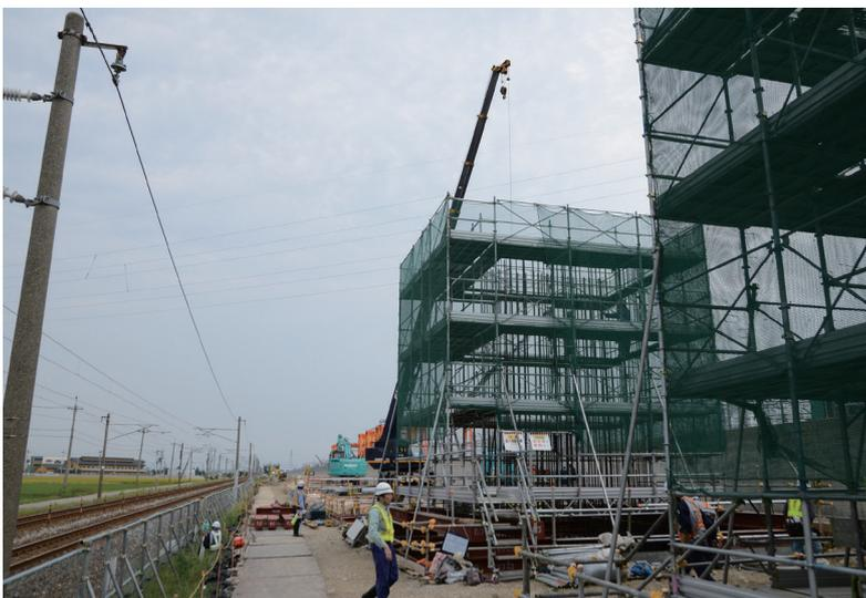
車両基地と線路に挟まれた白山宮保の高架橋現場。JR北陸本線の通過時は、重機作業を停止する
