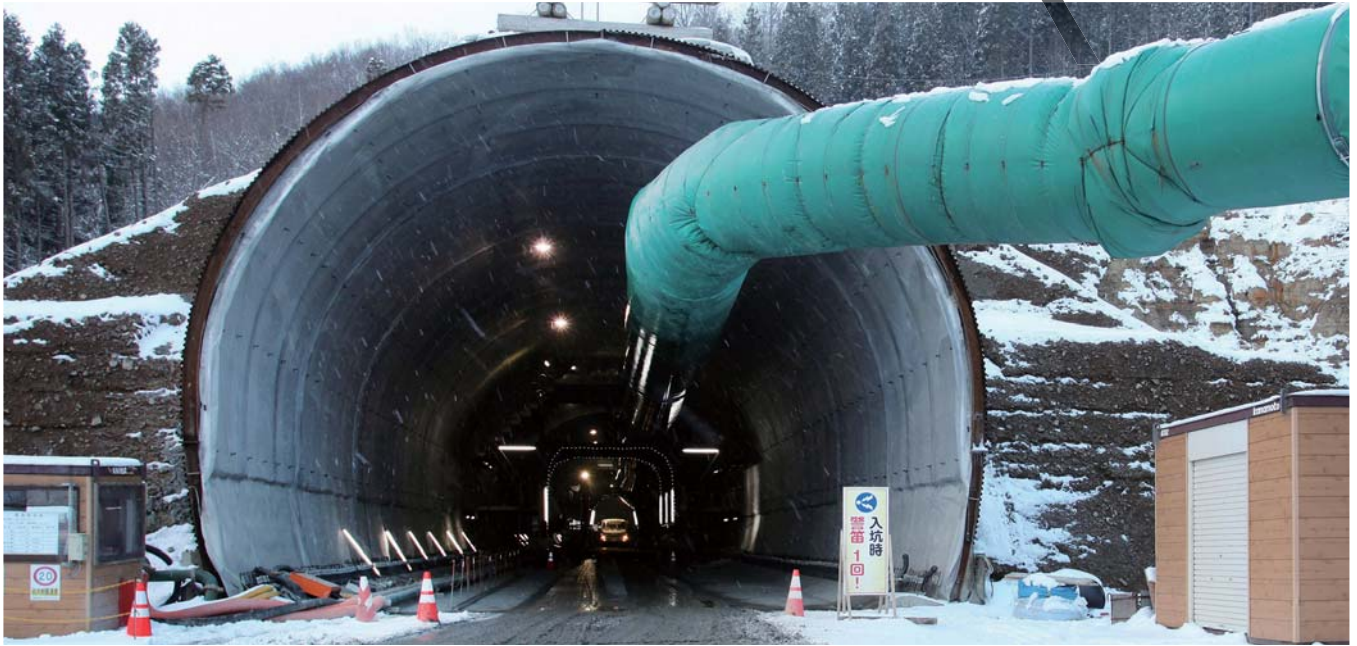
丘陵を掘進する立岩トンネルの坑口。冷たい風が吹き付ける厳しい環境の中、昼夜交代で作業は続けられる
