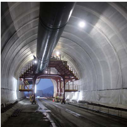
防水工の施工状況（立岩トンネル）
