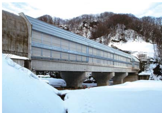
写真2 スノーシェルター
