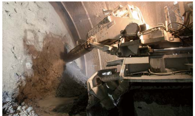
自由断面トンネル掘進機による掘削状況（立岩トンネル）
