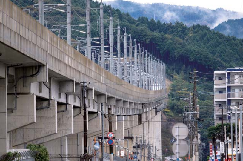
博多南駅前から、梶原トンネルへ向かう35%区間を望む。ちょうど上り「さくら」がやってきた
