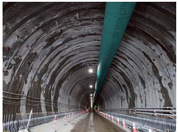
野田追トンネル（北）他工区の坑口からとらえた坑内の様子。天井のパイプは新鮮な空気を坑内に送風するためのダクトだ
