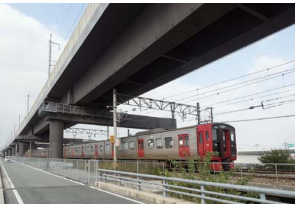
松原線路橋の下を博多行き普通列車が通過。直上高架橋でありながら圧迫感が少なく周囲とも調和している
