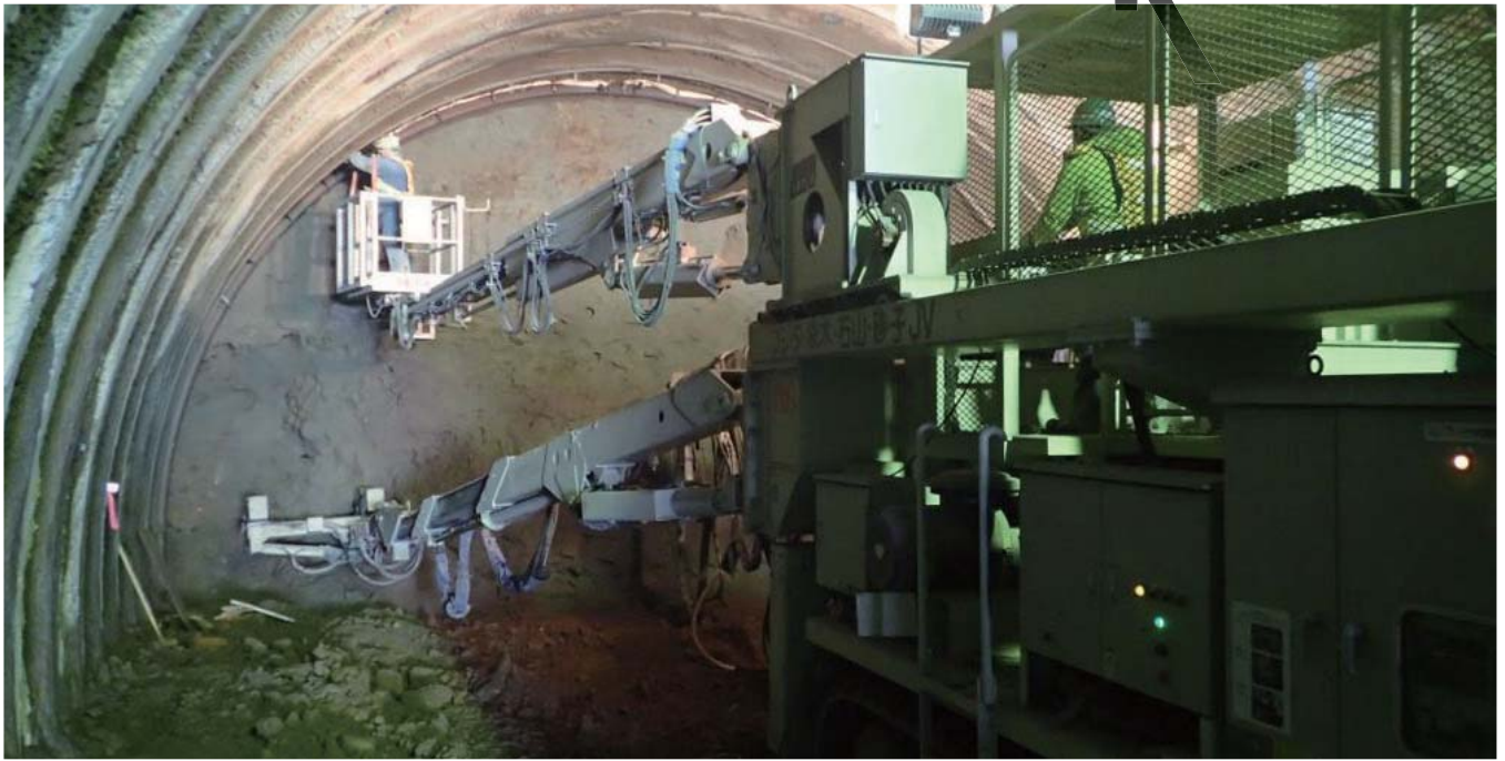
エレクター一体型吹付機を用いた鋼製支保工建込状況（野田追トンネル）
