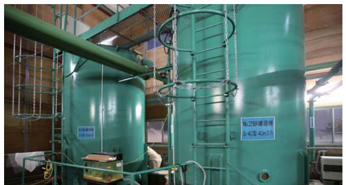
立岩トンネルの現場では、坑内から排出された水を浄水するシステムが確立され、濁水処理設備にて処理された水で金魚を飼育している
