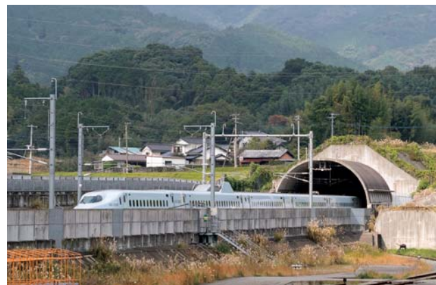
九州新幹線最長の筑紫トンネルを出て新鳥栖駅構内に入るN700系「みずほ」
