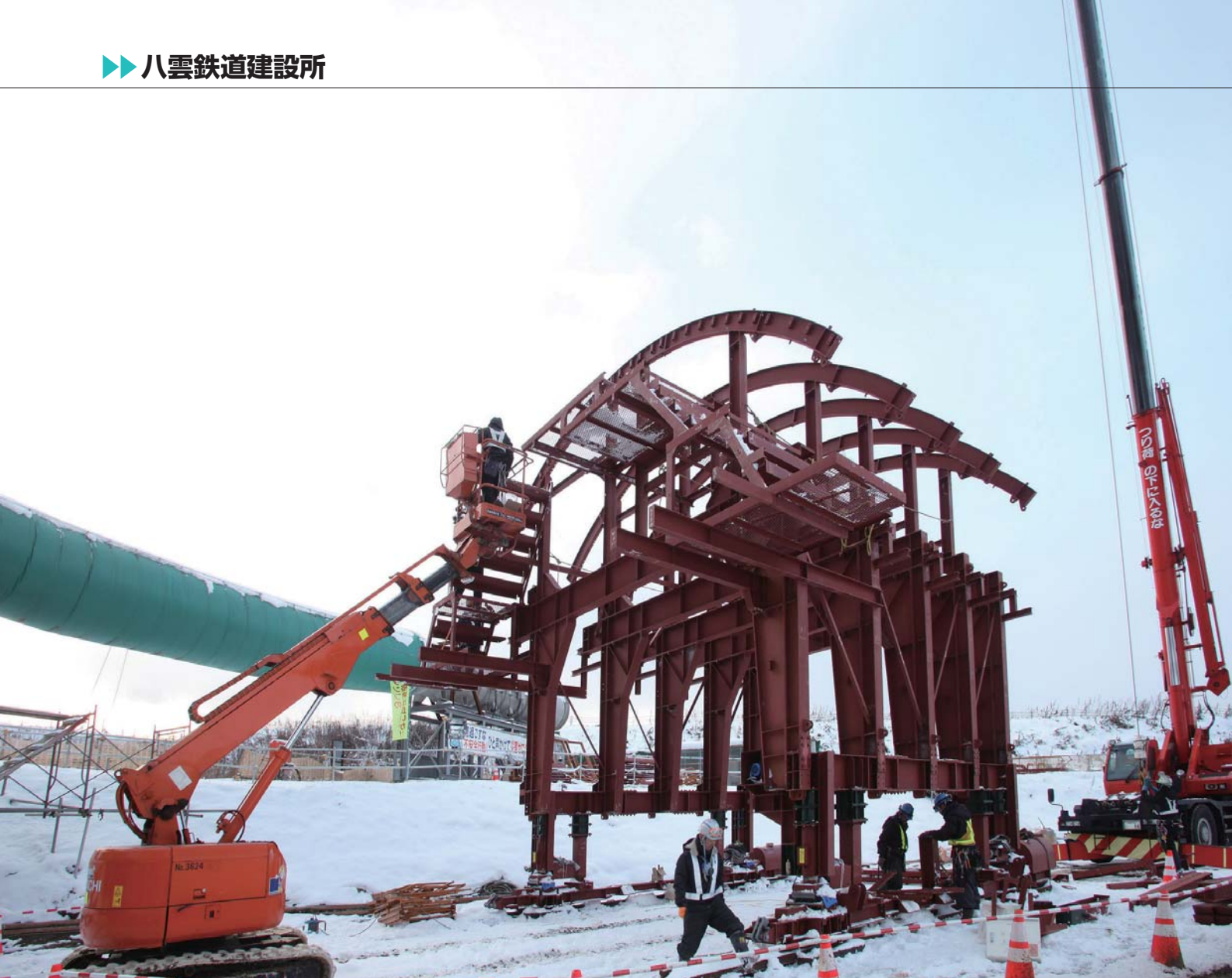
不安定な天候の中、懸命な作業が続けられていた、野田追トンネル坑外の様子
