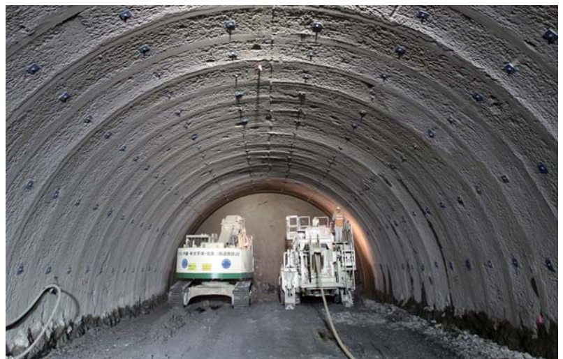
立岩トンネルの掘削状況。大型ブレーカ（左）と自由断面トンネル掘進機（右）にて連携しながら掘削していた
