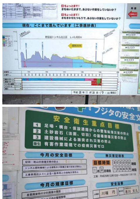
現場入口に掲示された、工事の進捗状況や月間目標。毎日実施される、作業開始前のミーティングで確認し合う
