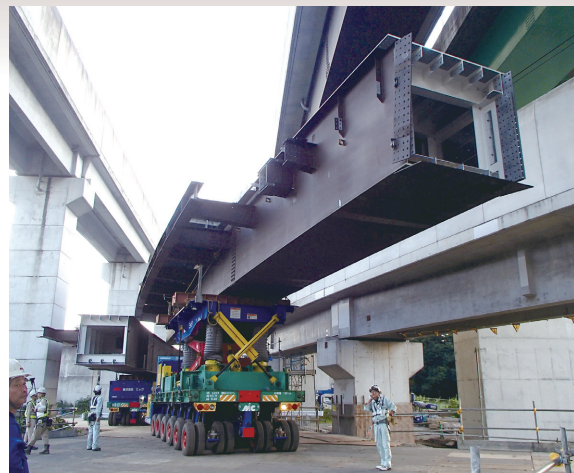
鉄桁架設
