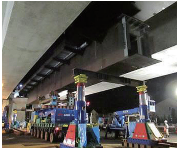
鋼桁架設
