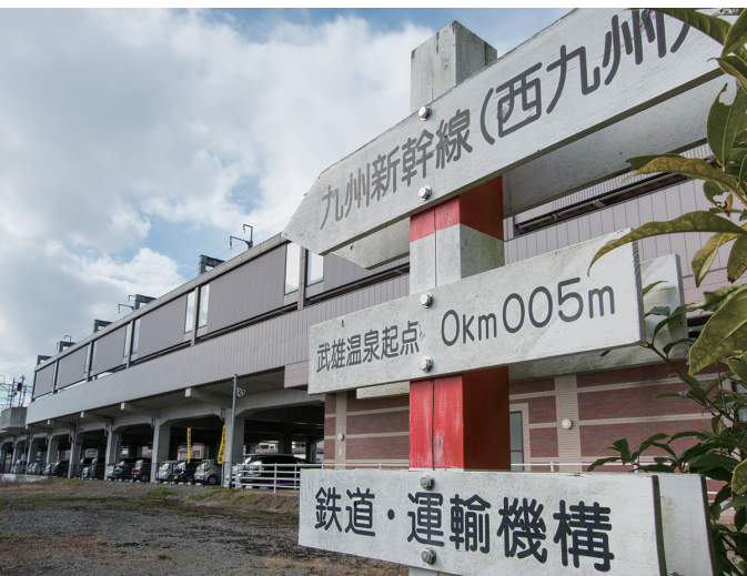
武雄温泉駅の南口に設置された、紅白の中心線表示杭・通称「トンボ」。この標柱の位置に九州新幹線の構造物が建設される
