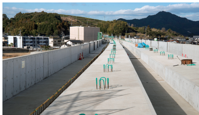
嬉野温泉（仮称）駅の高架橋上から起点方を望む。構造物がカーブしているのが分かる
