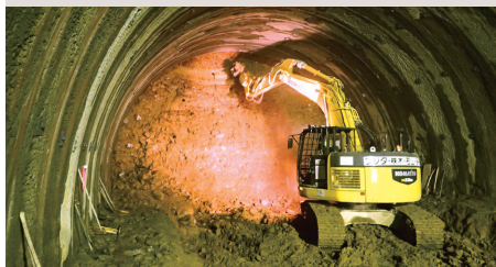
野田追トンネルの掘削状況（八雲町）
