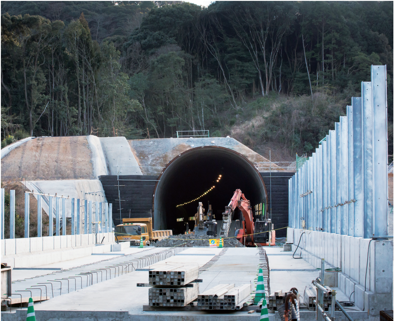
全長 1,380m のトンネルを軸とした、「武雄トンネル外 1 箇所他」工区の風景。至近距離にある住宅地への配慮か、通常の掘削現場より作業音が小さく感じられた
