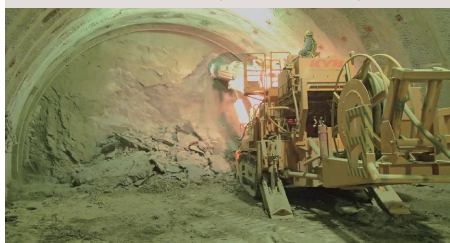
加賀トンネルの掘削状況（加賀市）
