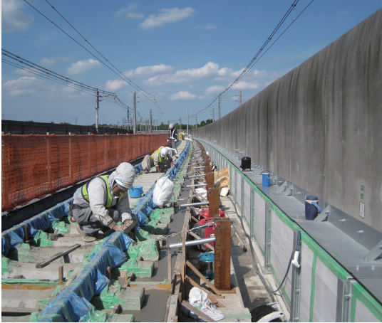
コンクリート打設
