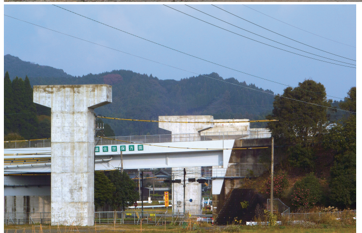
高速道路と国道を跨ぐように作られる袴野橋りょう。高速道路と国道の双方を跨ぐため、橋脚の高さは20mを超える
