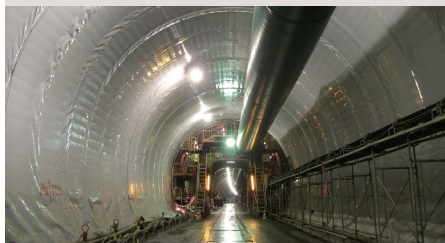
渡島トンネルの施工状況（北斗市）
