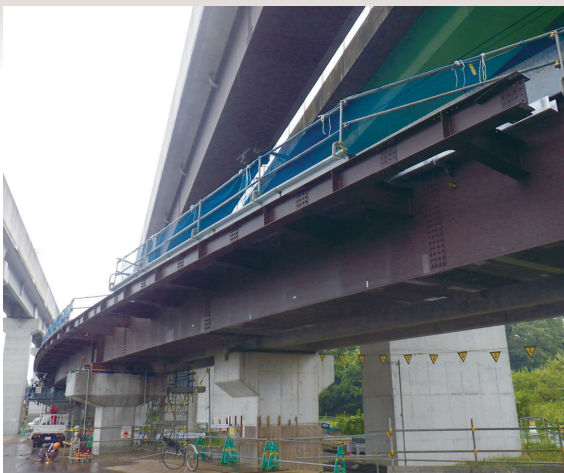
鉄桁架設
