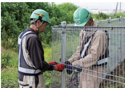
二人一組で柵を設置していく。細かい作業にはチームワークが不可欠
