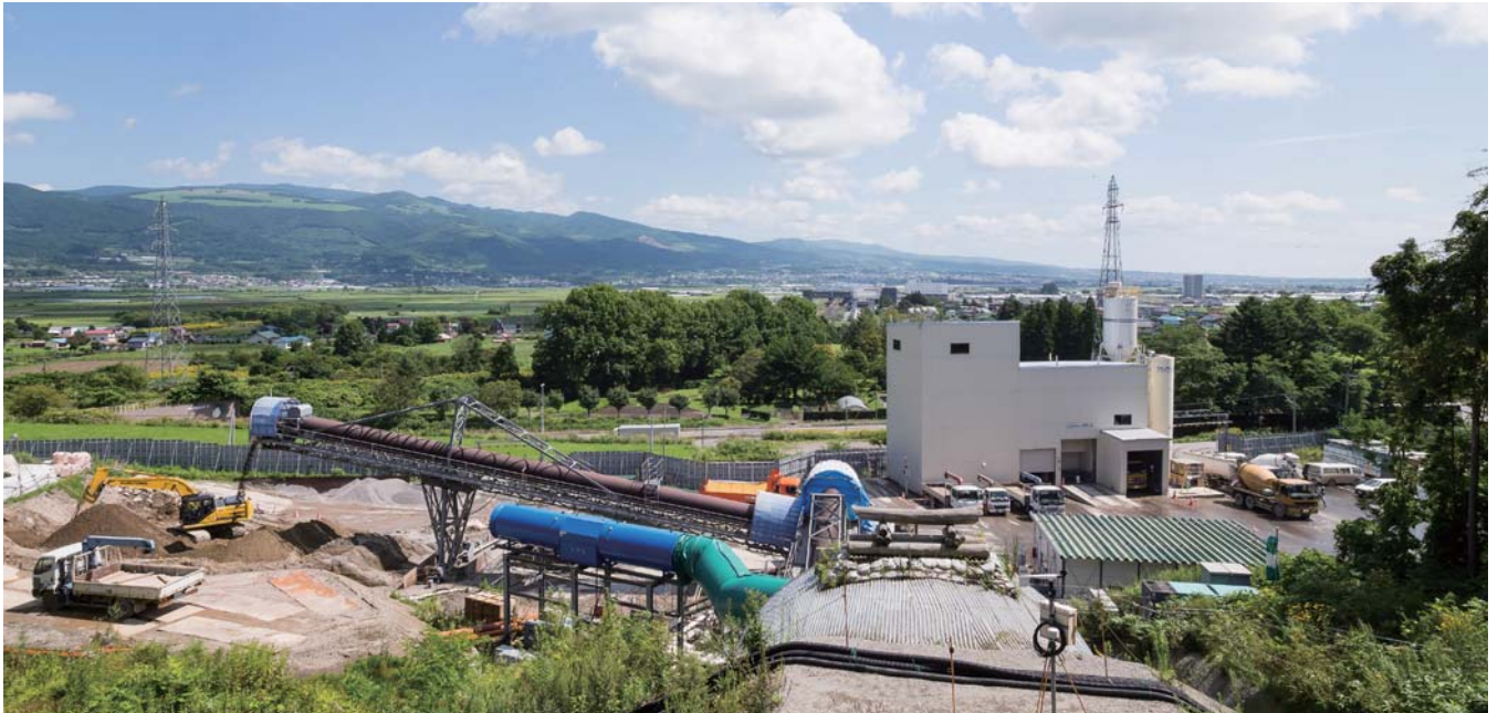
本坑入口からは、前方の木々の向こうに新函館北斗駅の連絡通路が見える
