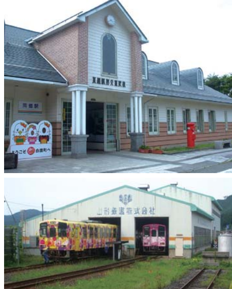
荒砥駅の駅舎(上)と荒砥車両基地(下)
