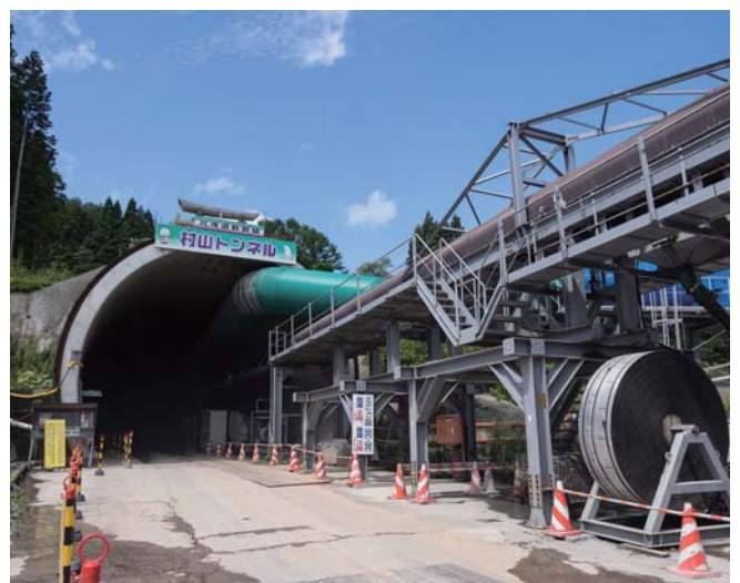
村山トンネルの本坑入口。渡島トンネルへの編入が決まったが、発注の関係で工事中は「村山トンネル」の名前が残る
