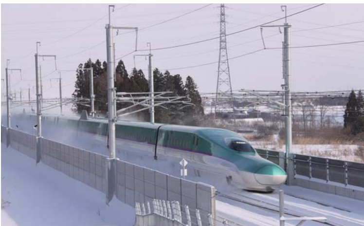
北海道新幹線（新青森・新函館北斗間）走行試験の状況
