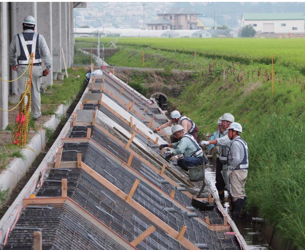
法面工を施工する高橋建設の作業員たち。コンクリートを流し込み、手作業で丁寧に仕上げていく
