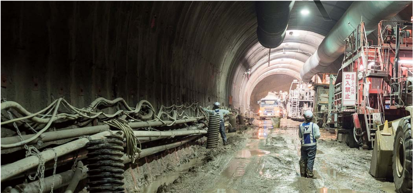
本坑の両脇には給・排水管が延びる。水抜き方法は、村山トンネル着工以来改良とコストダウンが重ねられている
