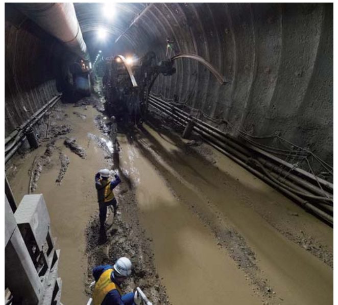
切羽付近の地面は湧水でぬかるんでおり、場所によってはくるぶしまで沈み込む。この後、碎石を敷き詰めて人や重機の往来をしやすくする
