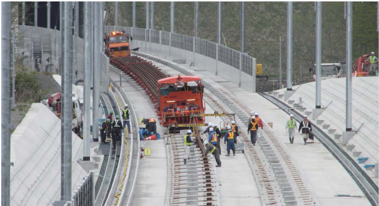
北海道新幹線（新青森・新函館北斗間） 軌道工事状況（施工中当時）
