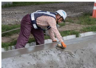
この道40年以上の職人技が光る法面工。垂れないよう、繊細なこて裁きが必要だ
