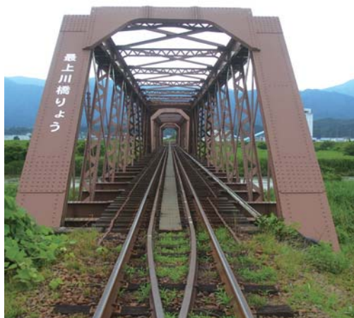
最上川橋りょうは、明治時代に造られた錬鉄製だ
