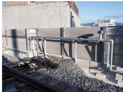
分岐器付近には散水消雪機が設置されている
