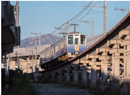
2つの高架線に挟まれた仮線を駆け上る福井行き電車。架線電圧600Vながら力強く上ってくる
