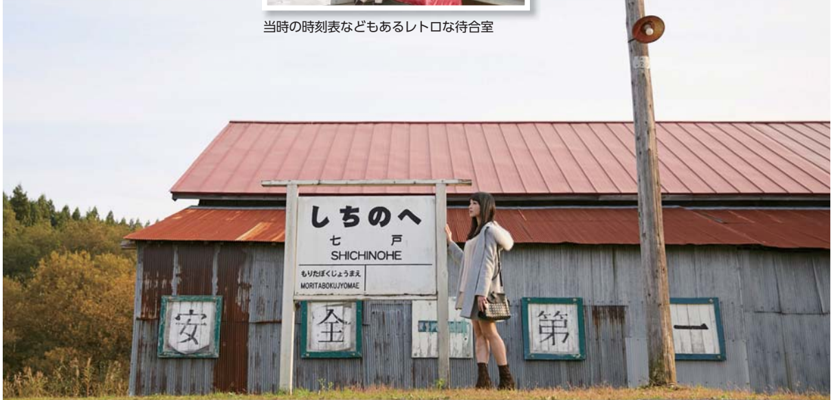
日本の原風景ともいえる七戸駅のプラットホーム
