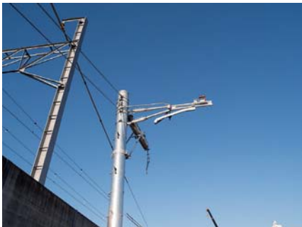
架線の設置を待つ電車線柱。き電ちよう架線方式を採用し、左の仮線よりもさらにシンプルな構造となった
