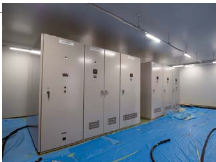
コンパクトな電気室。計画線には変電所が含まれないため、電車を動かすための電気は扱わない
