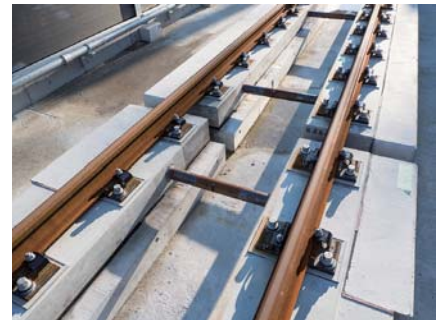
レールと並行に PC 縦梁を置き、継管で補強するフローティング・ラダー軌道。深さがあるので、ここに雪を溜めることができる
