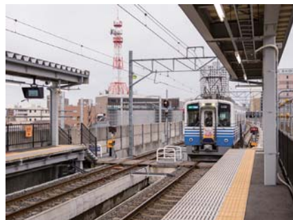
仮線の福井駅に進入する三国港行き列車。新幹線用の高架線に構内踏切が設置され話題になった
