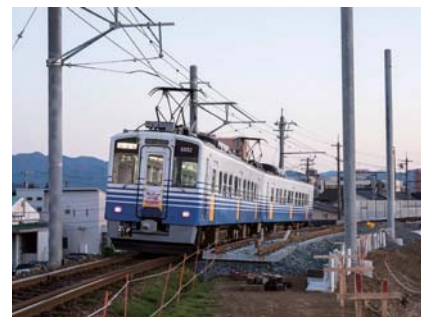
合流部には線路の高さに若干の差が生じる。既存線の線路をかさ上げして調整する予定
