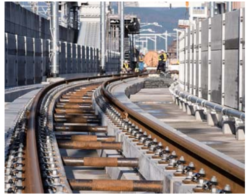
主要幹線と同様 50N レールが使用され、最新のフローティング・ラダー軌道が採用されている。次の新福井駅まではわずか 300m だ
