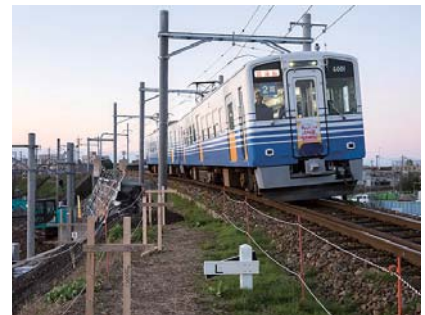
三国芦原線合流部を通過する電車。後方の仮設法面の位置で北陸新幹線と立体交差する予定
