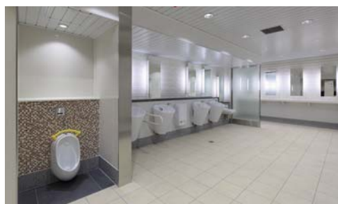
写真12 女子トイレ幼児用小便器（北陸新幹線、富山駅）
