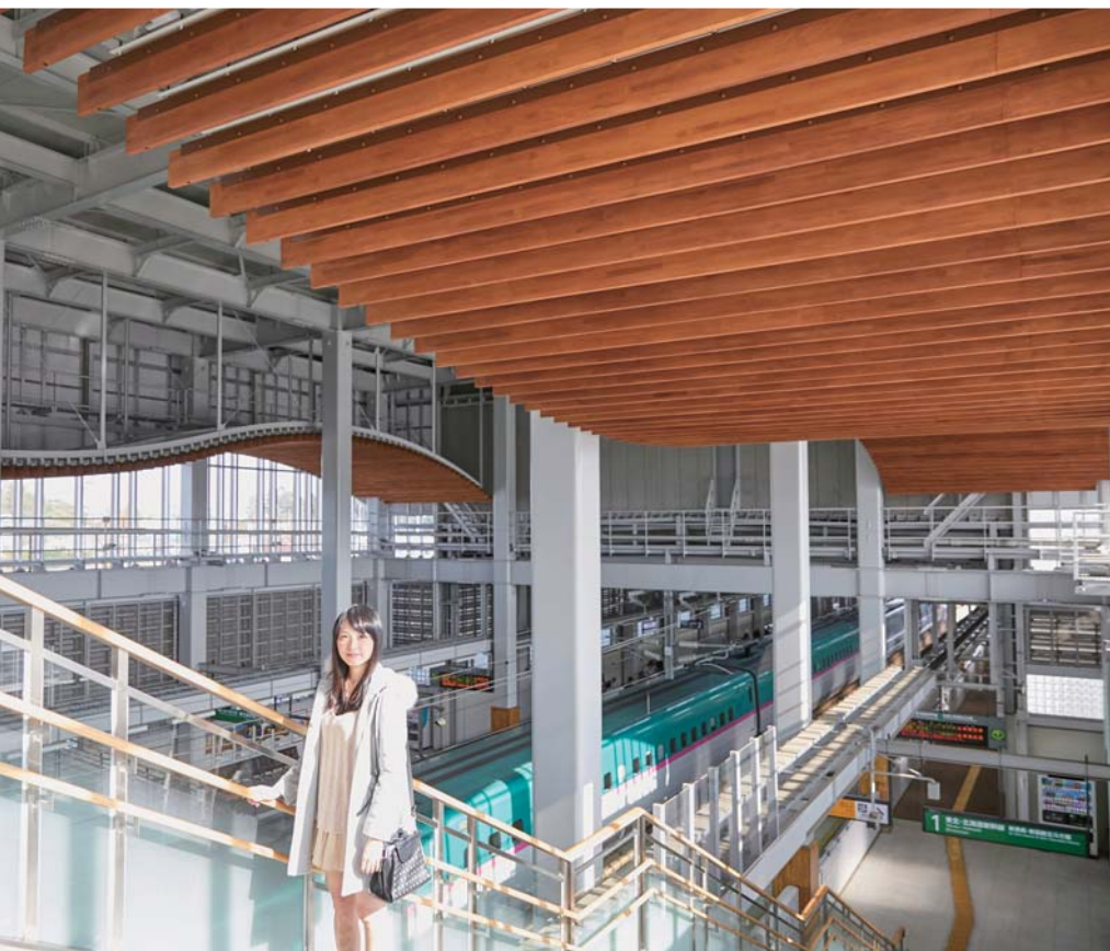
柵内コンコースからホームに降りる階段天井には、県産ヒバ材によるルーバー天井を用いている
