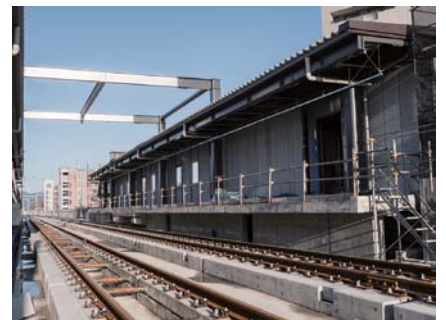
新福井駅のプラットフォーム。上下線それぞれに入口を設けるが、下り線用の階段・エレベーターは仮線用として既に供用されている
