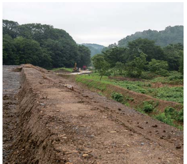
受入地の盛土周囲には粘性土による覆土が行われ、重金属類等の流出を防ぐ
