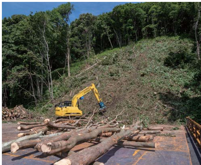
内浦トンネル（静狩）他工区の坑口予定地。この辺りの山は道が管理する保安林のため、伐採する範囲も最小限にとどめられている
