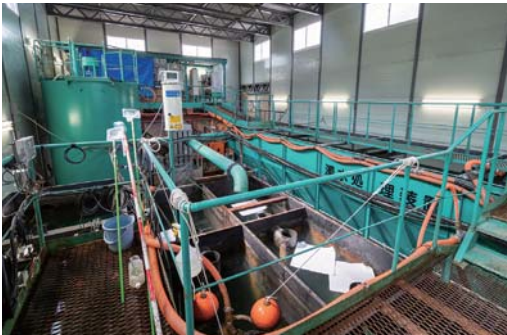
水を浄化する濁水処理施設。PAC（ポリ塩化アルミニウム）の化学反応を使って水中の粒子を凝集させ、水と分離させる
