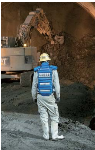
切羽の状況を監視する切羽監視員。今年1月にガイドラインが変わり、専任で置くことが明確化された
