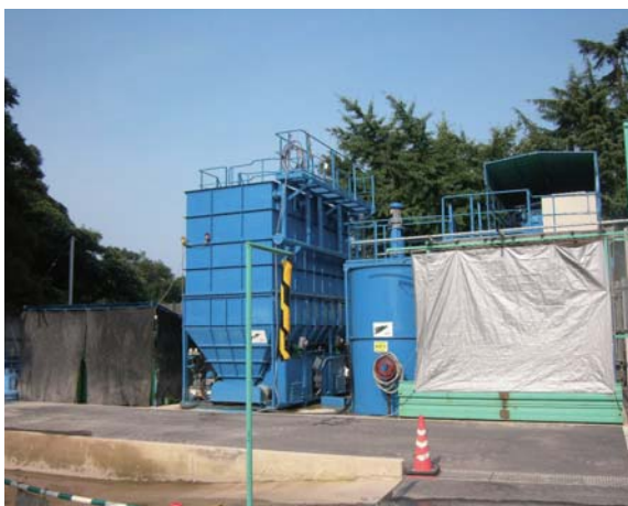
濁水処理設備
