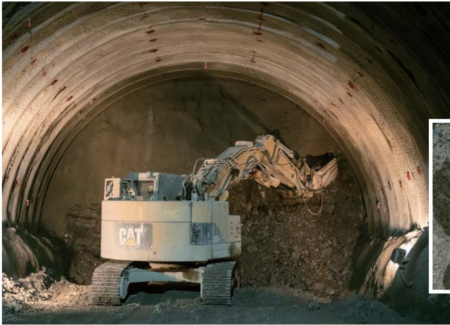
補助ベンチ付全断面工法を採用し、まずは本坑の上半分を掘削する【立岩トンネル(ルコツ)工区】
