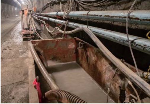
切羽からの湧水は現在 50ℓ と少ないが慎重に調査・監視が続けられている
