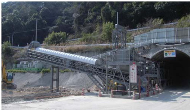
ベルトコンベヤによる土砂搬出
