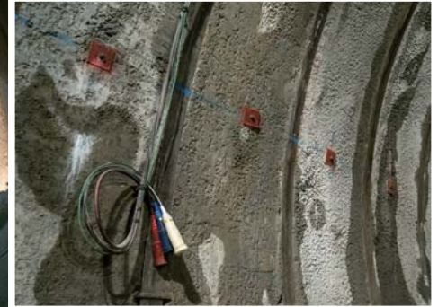
約1m掘り進むごとに鋼製支保工を設置し、その間にロックボルト(赤いマーキング)を打設する。地山の状況によって支保工の間隔は適宜調整される
