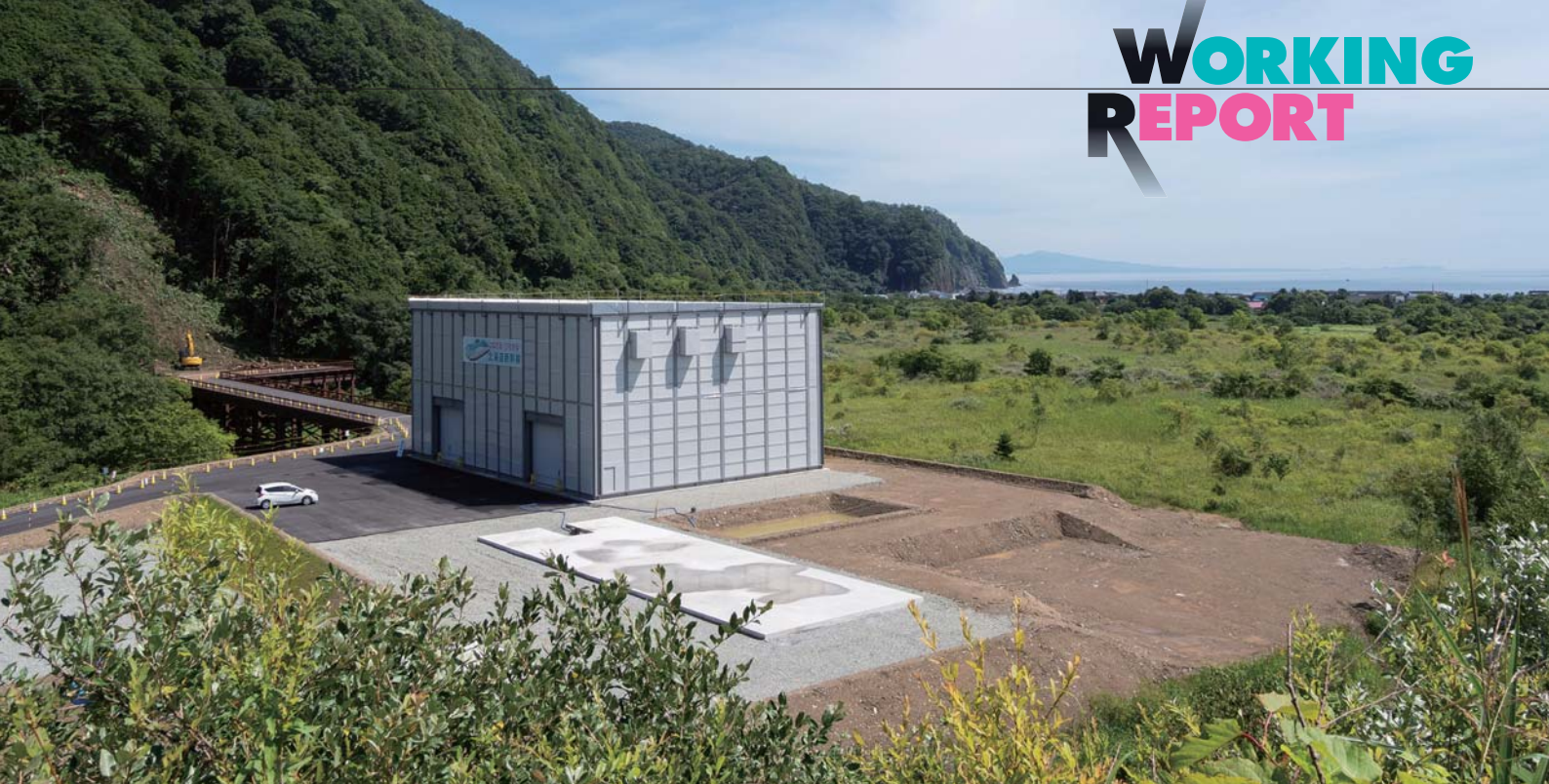
噴火湾を見晴らす内浦トンネル（静狩）他工区の施工ヤード。防音ハウスは発生土の仮置き場として使われる
