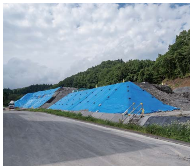
立岩トンネル(ルコツ)工区の施工ヤードに積まれた発生土。現在は対策土が出現しており、周辺に拡散しないよう対策が施されている
