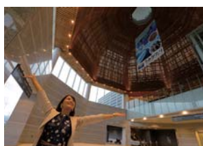
地場の杉材を用いた木組みのもてなしドームの天井
