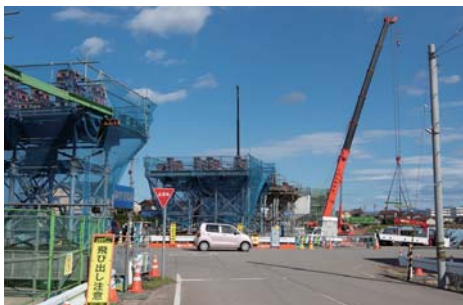
第3矢田野橋りょうでは前後の桁をクレーンで設置する作業が行われていた
