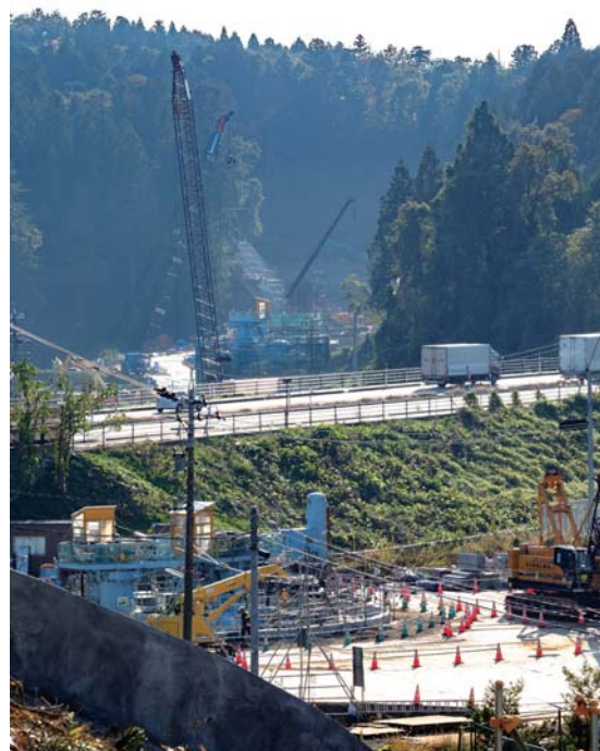
細坪橋りょう予定地。高い盛土の更の上に越すため国内の鉄道橋最大の支間長となるエクストラード橋が採用された
