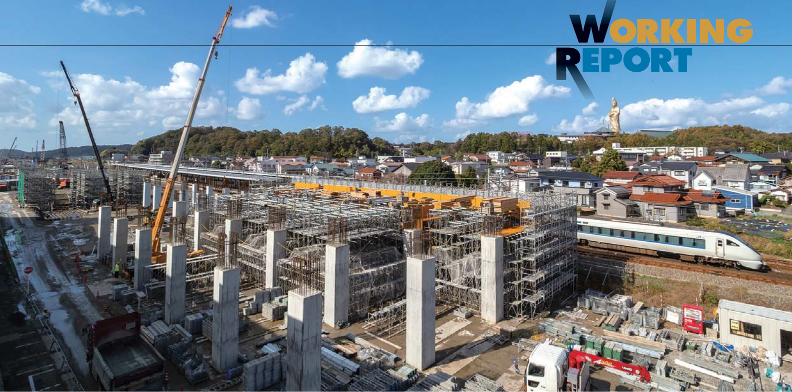
現駅併設で建設が進められている加賀温泉駅。通過線を備えた相対式2面4線の駅となり、駅西側には保守基地を備える
