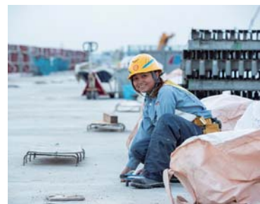
動橋川橋りょうの現場で作業に従事するスーミヤットウェイさん。この日は鋼管の腐食を防ぐPCグラウトの充填作業を行っていた
