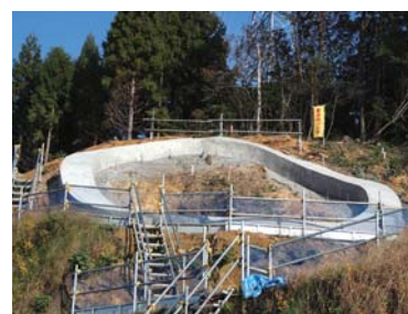
竹を斜めに切ったような形になる、竹割土留工法による橋脚基礎
