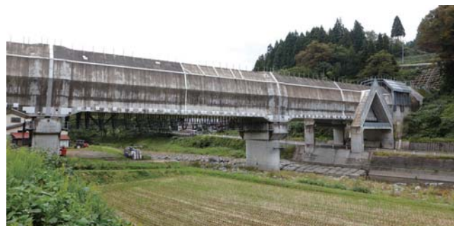
重厚感溢れる峰山トンネル付近のスノーシェルター
