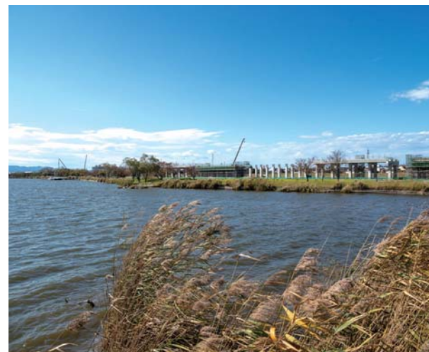
加賀・小松の自然を象徴する木場潟と北陸新幹線高架橋。沼地に近い地質で、新幹線の本線で初めて斜杭基礎が採用されている
