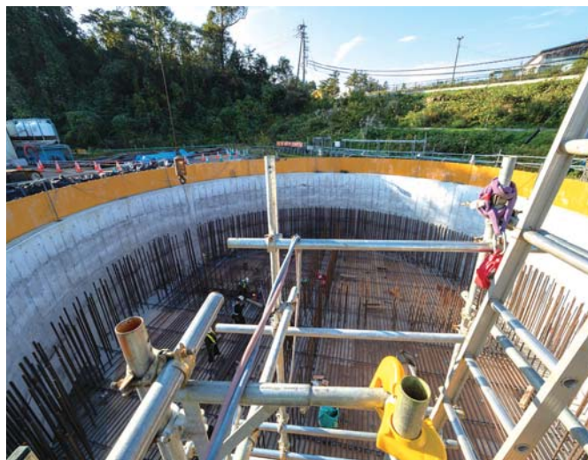
ニューマチックケーソン工法で建設されている細坪橋りょうの基礎。隣の橋脚まで155mもあるため、直径20mにもなる
