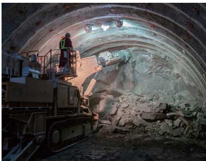
加賀トンネル中工区の金沢方切羽。柔らかい泥岩に適した自由断面掘削機で掘っていく。JR北陸本線の直下を通過しており細心の注意が必要である
