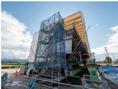
県道横のピットに搬入され架設の準備が進められている第3矢田野橋りょうの合成桁
