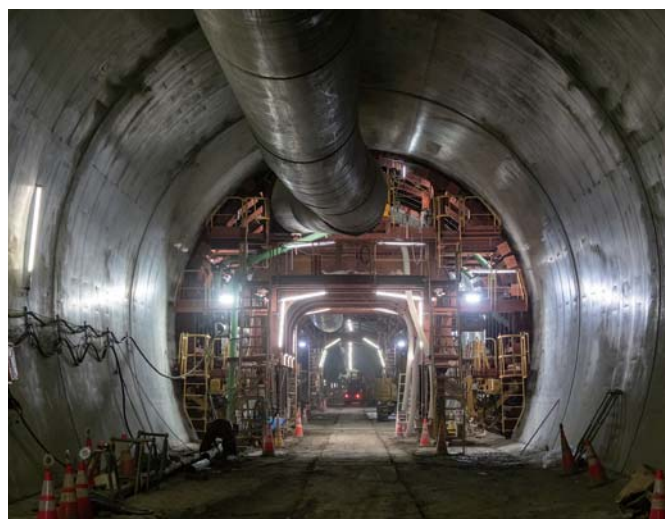
コンクリートの打ち込みは移動式型枠で順次行っていく。斜坑が狭いためこうした大型の機械はトンネルの内部で組み立てる
