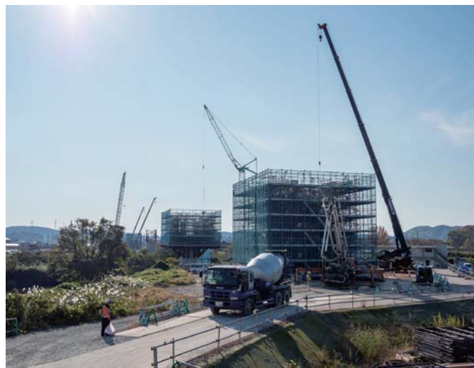
ニューマチックケーソン工法で建設されている大聖寺川橋りょうの橋脚。手前から二つめと三つめの橋脚の間を川が流れる
