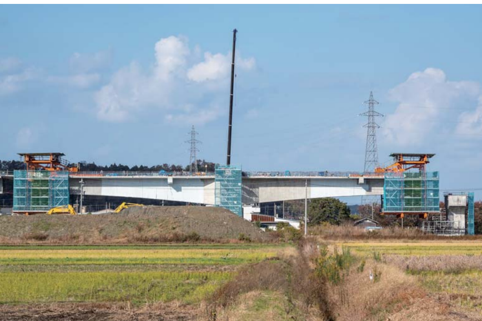
やじろべえのような張出架設工法がよく分かる、加賀温泉駅東方の八日市川橋りょう。中央の橋脚を支点に左右にバランス良く高架橋が延長されていく
