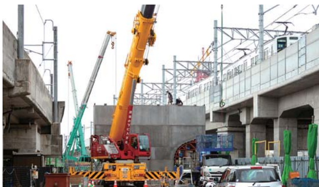
正面の橋脚は REED 工法を採用。福井口駅付近では左右に全く余裕のない状況で橋脚の建設が行われている。左端のバトライトはレーザーバリアの警報装置。右の車の陰には列車監視員も立っている
