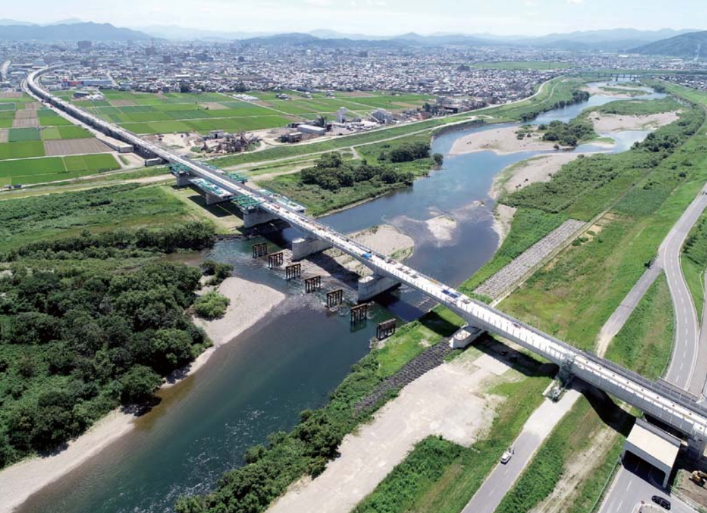
九頭竜川橋りょうの全景。上部工は新幹線のみ完成し、今後左右に県道の橋りょうが建設される。手前の鉄骨は建設作業に使われた栈橋の橋脚で、栈橋自体は出水期までに撤去されている
