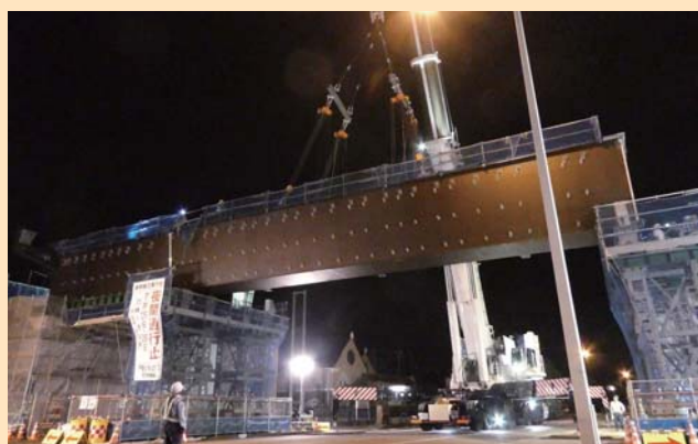
桁架設後の様子
