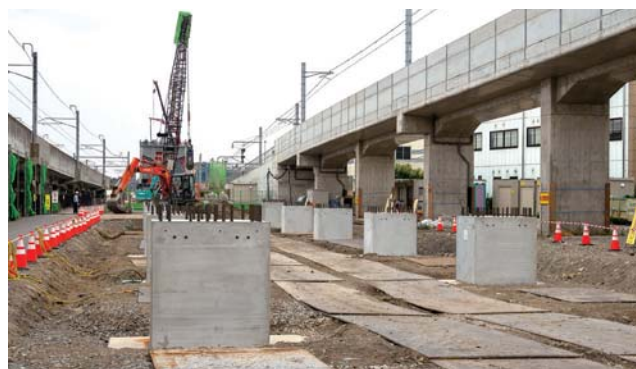
営業線近接部で構築が始まった、LRV 工法による橋脚。部材は茨城県の工場で製作されトラック輸送される。福井では生コンクリートが不足しており、その節約にも貢献した
