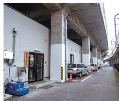
先行建設された福井駅部高架橋の下にある福井鉄道建設所。平成 18 年 7 月に開所した後、福井駅部完成後の平成 21 年 3 月にいったん閉所、平成 24 年 9 月 20 日に再び開所した
