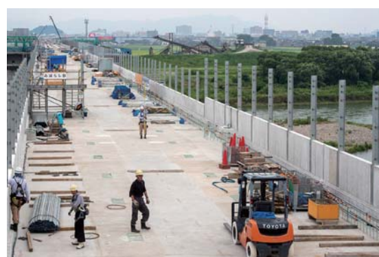
橋りょう上では防音壁の設置が進む。上部工は、橋脚を支点として左右に「やじろべえ」のようにバランスを取りながら延ばしていく張り出し架設工法が用いられた
