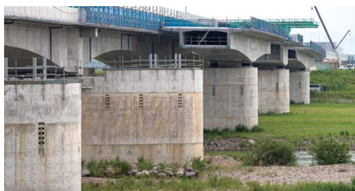
橋脚の下には構造物を守るための護床工（自然石）が設置されている。橋脚基礎は、地上で製作した函下部に作業室を設け、圧縮空気を送り込みながら沈めていくニューマチックケーソン工法で建設された
