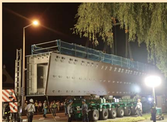
トレーターにより架設箇所まで運ばれた桁
