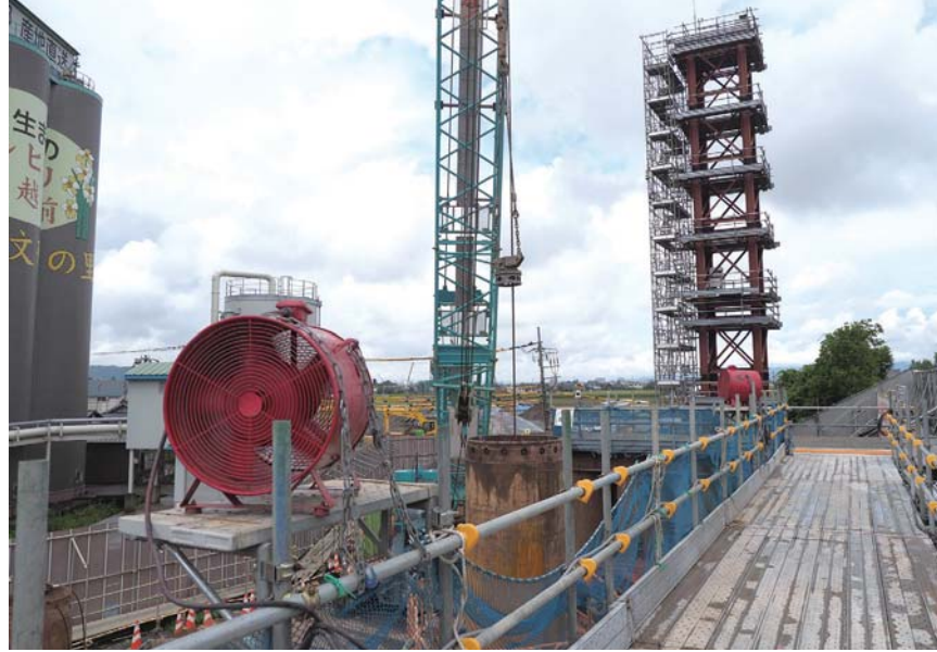
粉塵などが道路側へ飛ばないように、掘削現場の周囲では大型扇風機が稼働している
