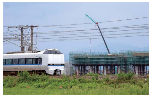
下叡生田橋りょうの建設現場を見ながら走る米原行き特急「しらさぎ」。中京地区と北陸の連絡を担う俊足特急だ
