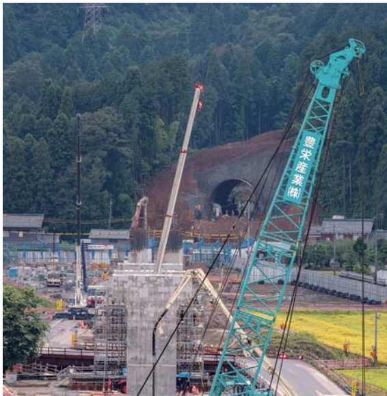
延長80mの第1福井トンネル。その向こうに延長3,520mの第2福井トンネルがあり、そのうち北側の1,630mを福井鉄道建設所が担当している。既に掘削は完了した
