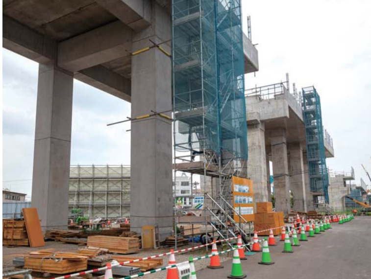
LRV 工法による高架（手前）と、従来工法による高架（奥）。LRV 工法は部材を積み重ねるように組み立てるので目地が見え、重機を入れるために左右の柱の間隔が広く取られている
