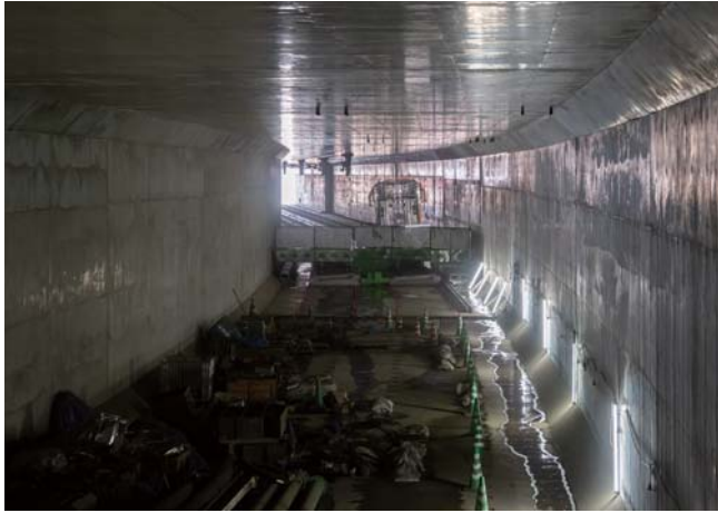
羽沢トンネルのうち、羽沢横浜国大駅方から約 150 mは開削工法による箱形トンネルだ。現時点での線路終端部と、建築限界測定車が見える
