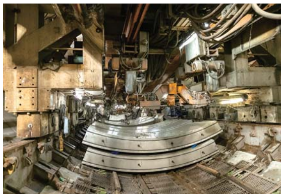
シールドマシン内部では、順次セグメントが構築されていく。幅1.2mの1リングを構築するのに、掘削を含めて約2時間かかる
