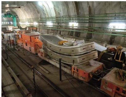
羽沢トンネル内での資材運搬はバッテリーロコで行っている
