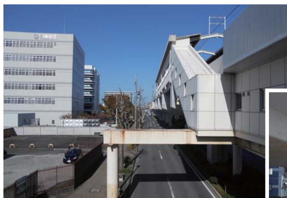
八幡駅付近の高架橋。 左に見えるビルはヤマハ本社
