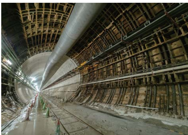
SENS で使用された内型枠。セグメントと同じ 1.2m 幅のリングが 16 リング並んでおり、一番後ろのリングを前に移し替えて前進していった。なお、SENS の由来については 12 ページ参照
