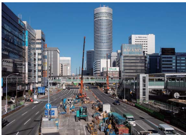
環状2号線に沿って駅の構築が進む新横浜駅前
