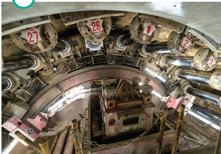
28本のジャッキが最前部のセグメントを押しつけることで、シールドマシンが推進力を得るとともに、セグメントはトンネル軸方向に固定される
