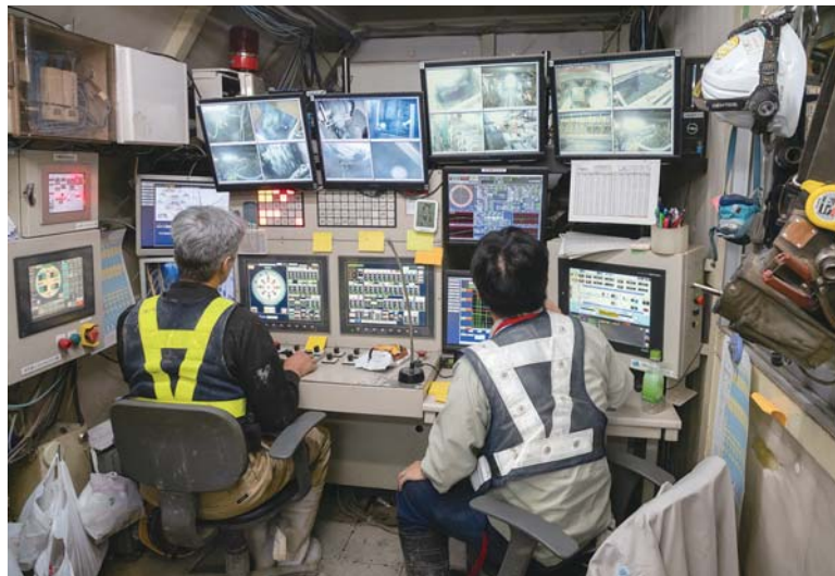
土圧やジャッキの状況などをモニターで確認しながらシールドマシンを運転する
