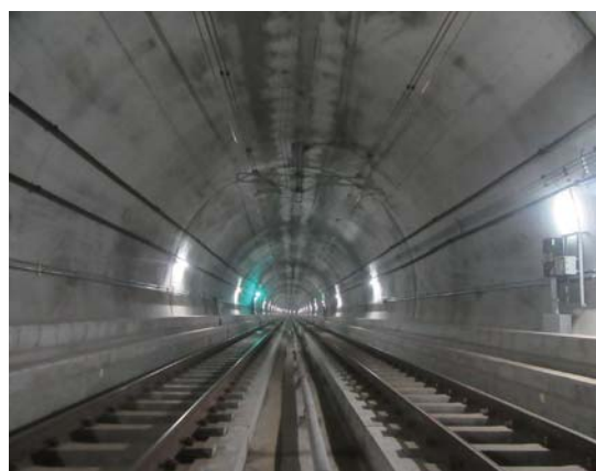
西谷トンネル
