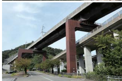
北陸自動車道の上を鋭角に交差する「北陸道架道橋」
