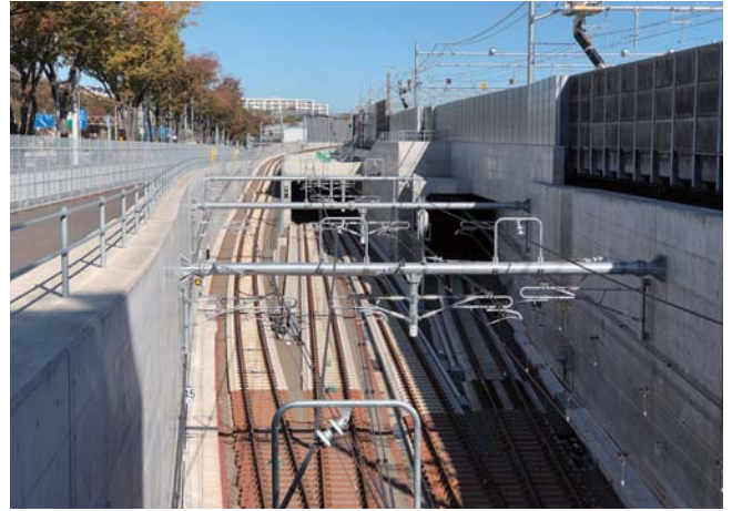
羽沢横浜国大駅から新横浜方向を望む。中央の 2 本が ST 線、左右の線路が SJ 線だ。JR 線との接続部は、JR 東日本に委託して工事を進めた
