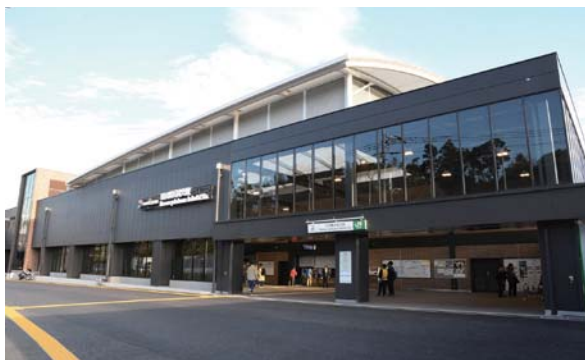
JR 貨物の横浜羽沢駅に隣接して開業した羽沢横浜国大駅。新横浜や保土ヶ谷へのバスが 1 時間に 1 ～ 2 本あるだけの不便な場所だったが、SJ 線の開業で渋谷まで最速 33 分で結ばれた
