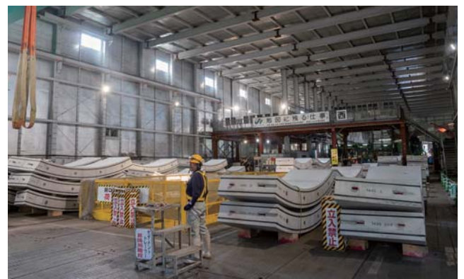
羽沢トンネル内への搬入を待つセグメント。中央の黄色い開口部から天井クレーンによって立坑内へ降ろす
