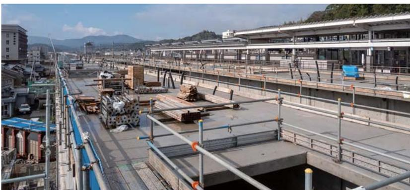
土木工事が完了したばかりの武雄温泉駅。従来構造のため、土木高架橋にエレベーターなどの開口部があらかじめ用意されている
