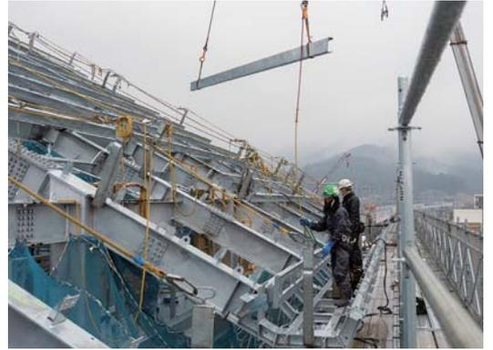
120トンクレーンで部材を上げ、屋根の鉄骨を組んでいく。現場は50～70人の作業員が従事している
