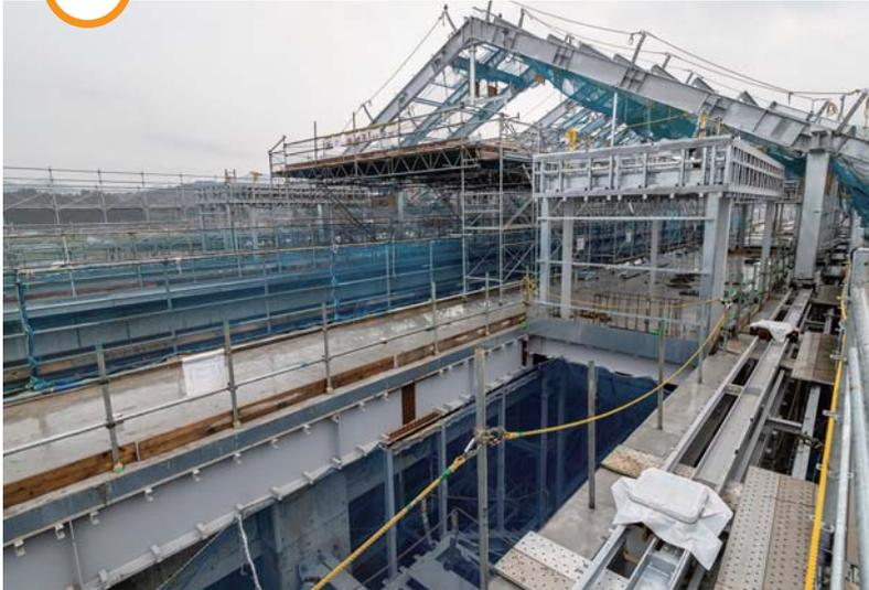
下り線ホームのエスカレーター開口部。駅とホームを結び昇降設備が高架橋の外側に建設されるので、土木高架橋とは別途に設計できる
