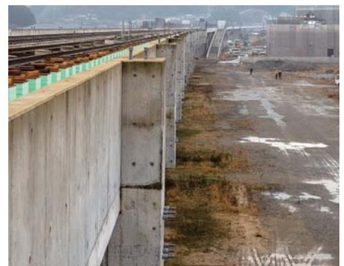
接続部には6本のアンカーボルトが準備されていた。この接続部の精度が極めて重要（平成31年2月9日撮影）
