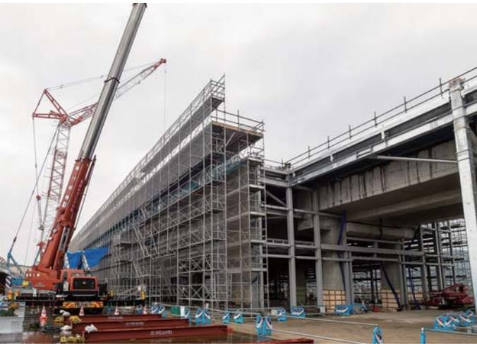
ハイブリッド構造の駅では土木高架橋を左右から覆うように鉄骨の柱や梁が構築されていく
