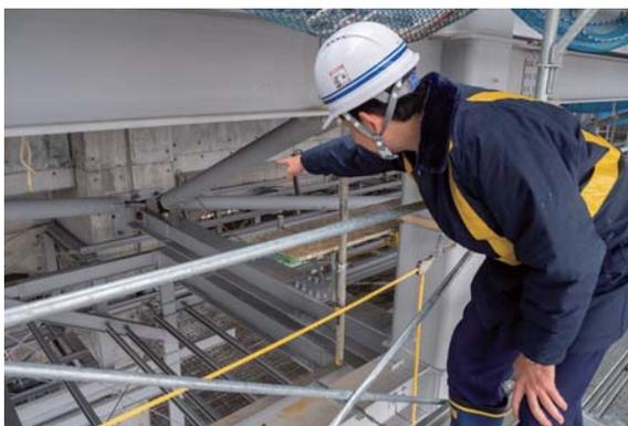
鉄骨フレームの接続部を指さして説明する菊田所長。ここがハイブリッド構造の施工管理の鍵となる部分だ
