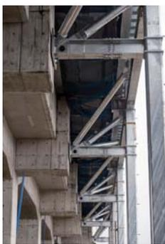
土木高架橋の側面に12.5m間隔で鉄骨フレームを接続。横方向の応力を高架橋に伝達する
