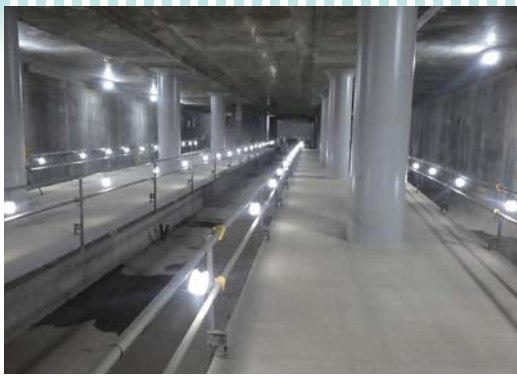
神奈川東部方面線（相鉄・東急直通線） 「建設が進む新横浜駅」
