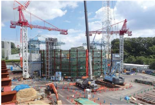
中央新幹線（非常口工事）
