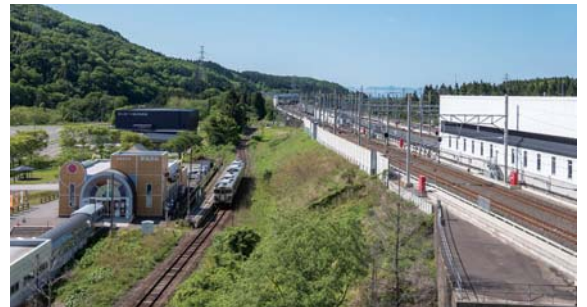
奥津軽いまべつ駅の連絡通路からは津軽線津軽二股駅と「道の駅いまべつ半島プラザアスル」が見える
