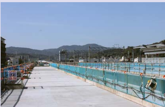
高架橋上より終点方（長崎方面）を望む
