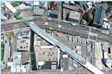
2回目架設完了写真（上空）
