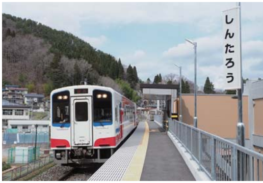
三陸鉄道 新田老駅 新駅設置（令和2年5月開業） 幹線鉄道等活性化事業費補助（助成先：三陸鉄道）
