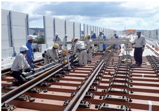
九州新幹線(武雄温泉・長崎間) 「軌道工事が進む新大村駅高架橋他」
