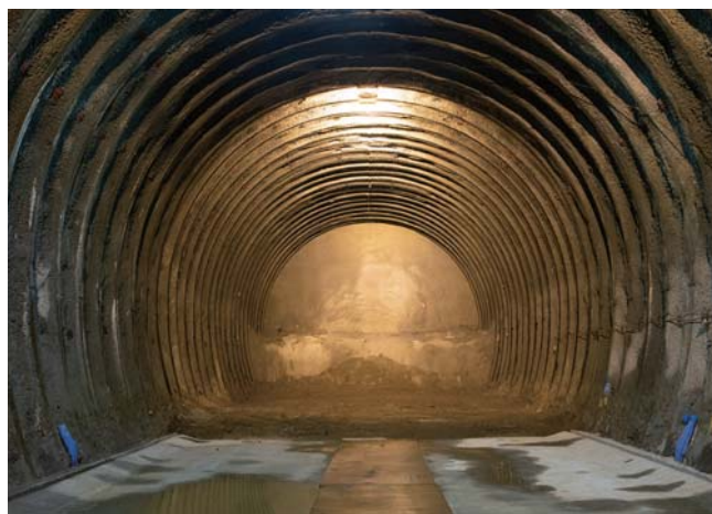
2月に掘削を完了し、宮田工区の貫通を待つ昆布トンネル桂台工区終端部。ベルトコンベアーなども既に撤去された
