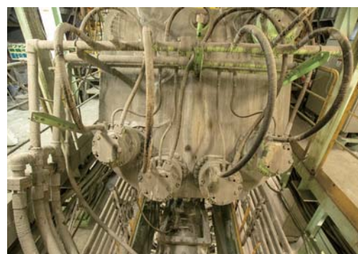
シールドマシン後方のスクリーコンベアー。豊富な地下水の水圧に対抗するために2段構造となっている。掘削された土や湧水は上段の筒に取り込まれ、土水圧をコントロールしながら下段の筒で受け止める構造だ
