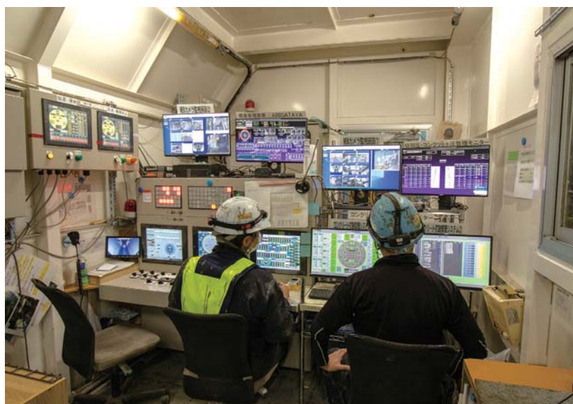
操作室では、常時2人の作業員が土水圧や切羽の状況を監視している。圧力が高まったり、センサーが硬い岩を確認したりすると、掘進速度を落とすなどして対応する
