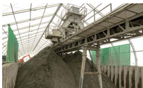
改質材を加えて処理された掘削土はずりピットへ。受入地である町営牧場へは、10tトラック30台が1日8～9往復して輸送している
