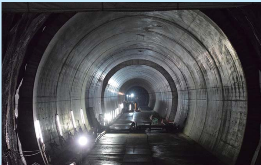
貫通点より葉原工区を望む
