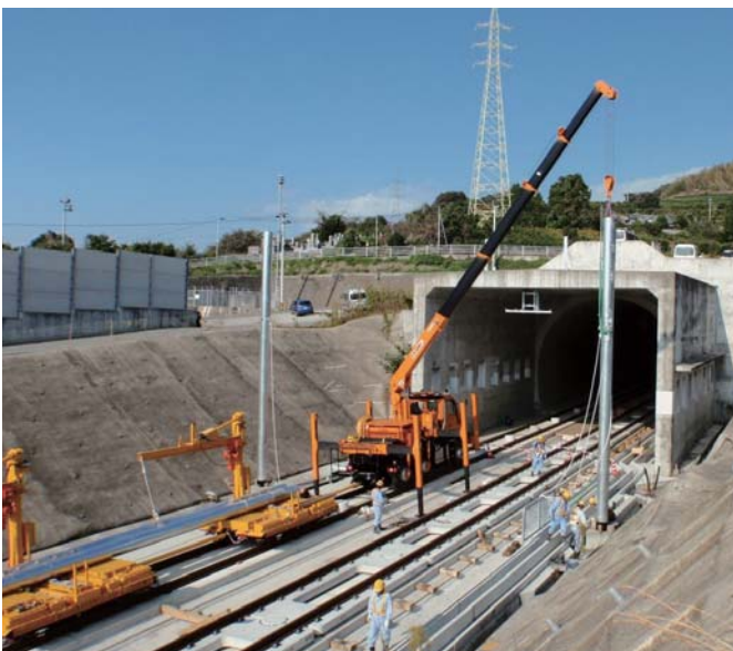
写真4：特種車（電柱建植用）
