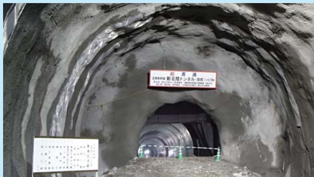
田尻工区貫通点
