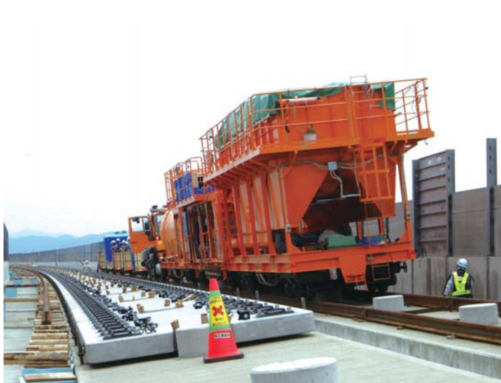
写真7：モルタル注入車
