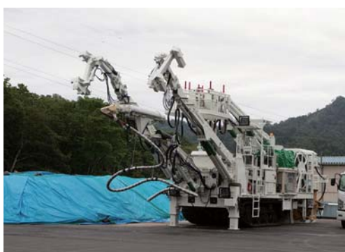
東川工区ではコンクリート吹付機も待機している
