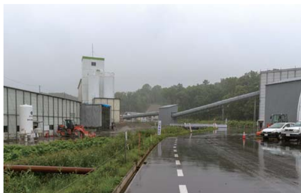
羊蹄トンネル比羅夫工区の坑口。切羽から搬出された掘削土は、ベルトコンベアーに乗って右手のずりピットに仮置きされる
