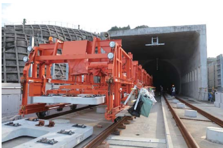
写真5：スラブ運搬敷設車
