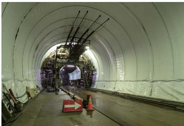
桂台工区では覆工セメントを使って仕上げる覆工コンクリート打設を行っており、残すは450mほどだ
