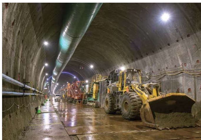
ニセコトンネルはNATMを採用。重機で掘削し、一定間隔で壁面へコンクリートを吹き付けてアーチ状の鋼製支保工を設置。再度コンクリートを吹き付けた後、地山に対して放射状にロックボルトを打ち込む
