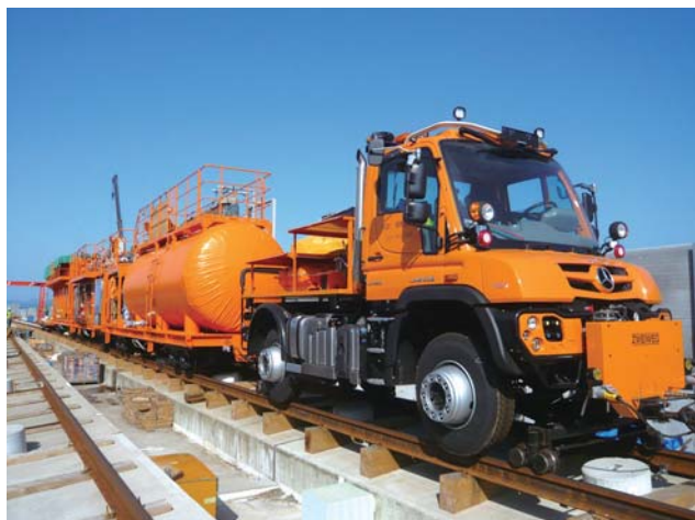
写真2：特種車（モルタル注入車をけん引中）
