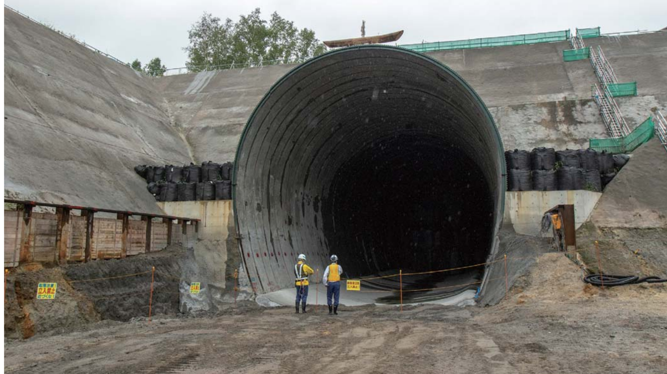
大型の礫が発見されたことから、50mのみ SENS から NATM に変更された有島工区。このまま冬を越し、来年春からシールドマシンの組み立てを行い、夏には掘進を開始する予定だ
