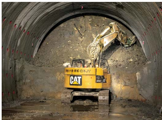
ブレーカー1台で崩せる、もろい地質のニセコ工区切羽。切羽を安定させるために、鋼管を打ち込んで薬液を注入する12本の鏡ボルトを実施
