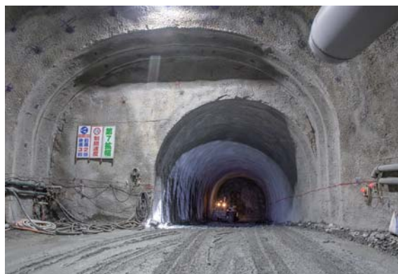
掘削が進む東川工区の斜坑。作業車が離合するため、ところどころで幅が広がっている
