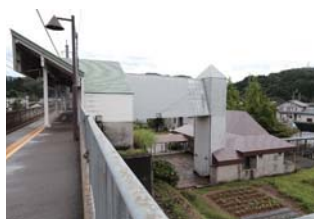
高架上に設けられた、うらがわら駅
