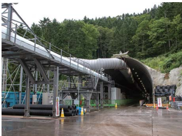
内浦トンネル幌内工区の坑口。自然由来の重金属類を含んだ対策土が発生する可能性がある工区で、慎重に調査と掘削が進められている
