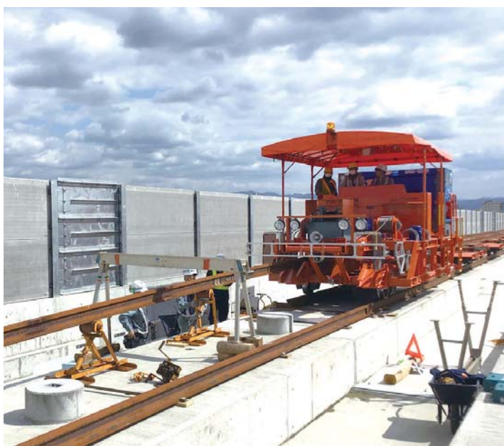
写真6：レール送り込み装置車
