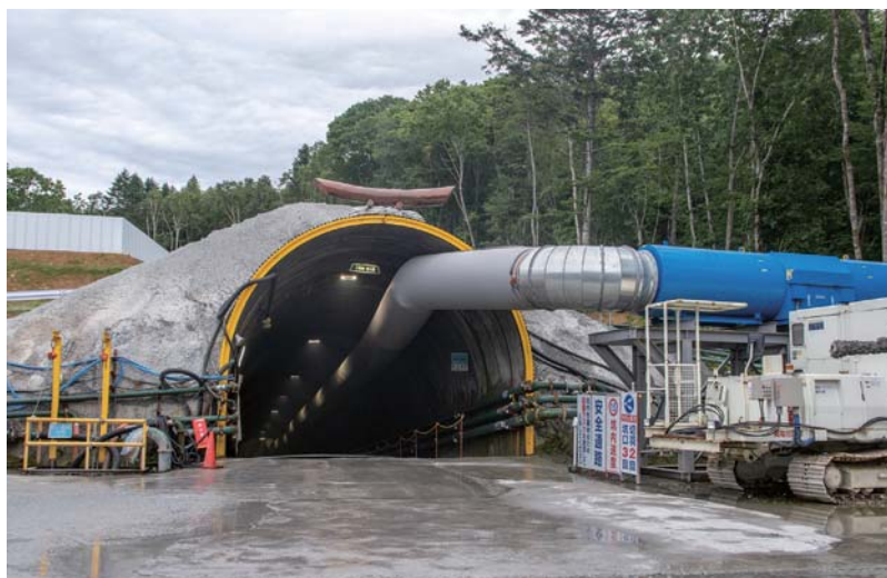
内浦トンネル東川工区の斜坑坑口。作業用のため、10%（100 mごとに10 mの高低差）という急勾配で地下へ下りていく。坑口の上には、神事の化粧木が備えられているのが見える
