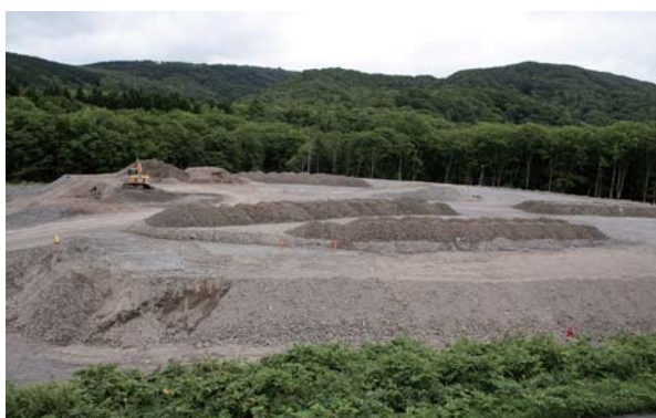
幌内工区の坑口近くには新幹線の変電所が設置される。無対策土（自然由来重金属等が基準値を超えない土）によって整地し、工事開始を待つ
