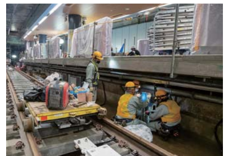
信号・保安装置関連作業
