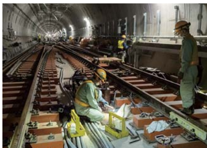
信号・保安装置関連作業
