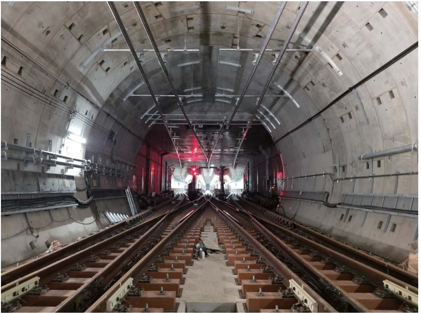
羽沢トンネルから見た新横浜駅
