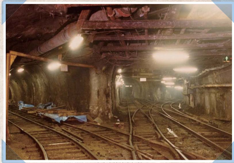
四方木立坑坑底部付近
