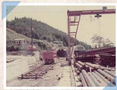
中山トンネル小野上南工区
