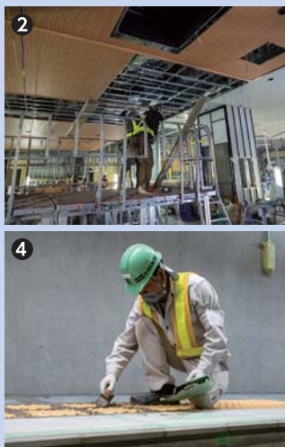
①ホーム ②コンコース天井の設置 ③ホームの駅名標 ④点字ブロック(誘導警告ブロック)の設置 ⑤電気室
