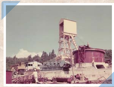
中山トンネル中山工区の立坑
