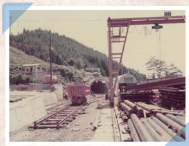
中山トンネル小野上南工区
