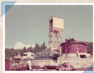
中山トンネル中山工区の立坑
