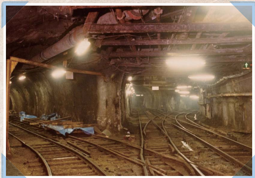
四方木立坑坑底部付近
