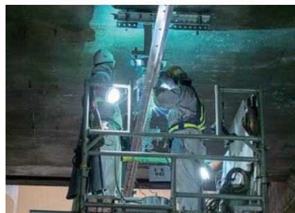
電車線設置作業 (アルミ架台を溶接中)
