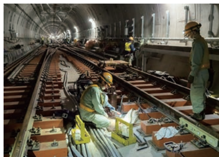
信号・保安装置関連作業
