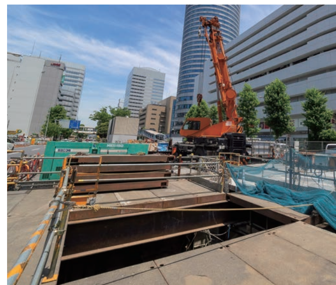
地上から見た新横浜駅の仮設開口部
