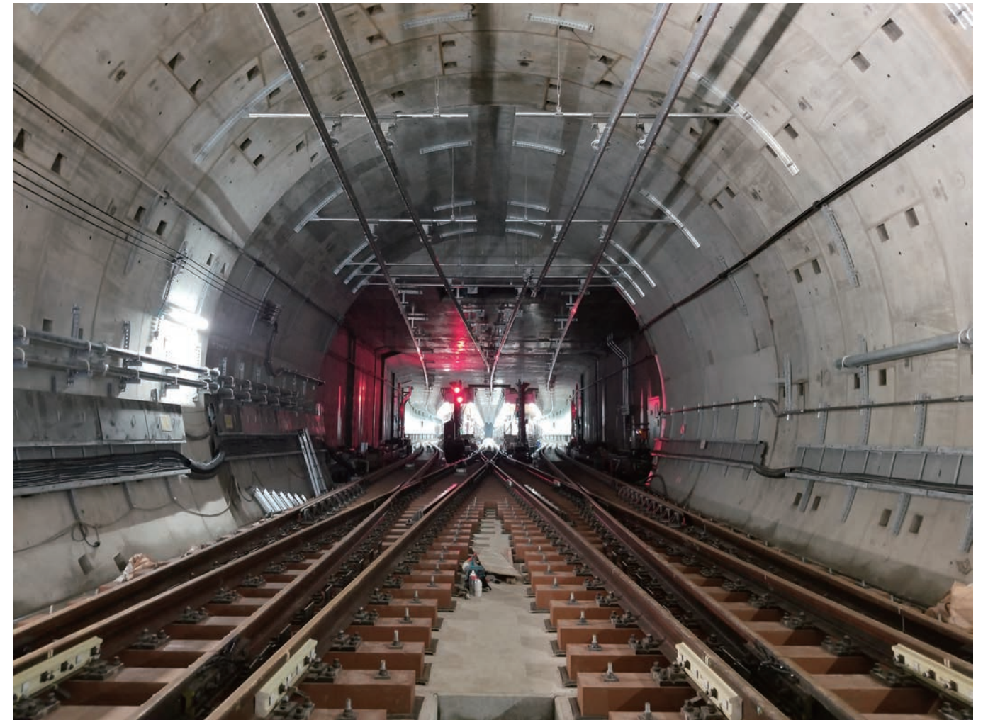
羽沢トンネルから見た新横浜駅
