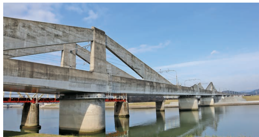
九州新幹線 川内川橋りょうの全景
