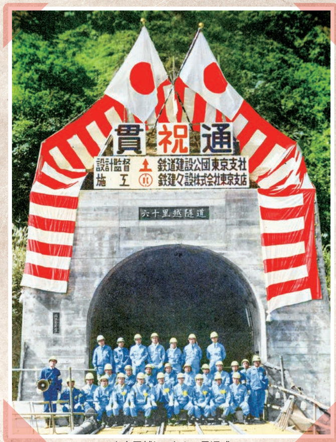
六十里越トンネルの貫通式
