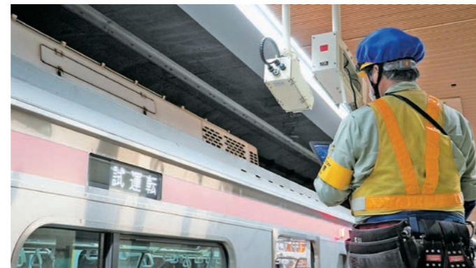
運転席やホーム端にあるモニター映像を確認しながらカメラの画角を調整する
