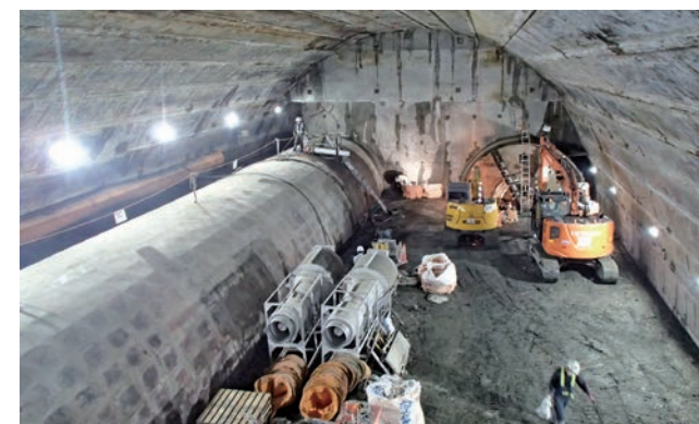
施工中の新綱島駅。地下から掘り進められている
