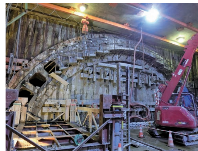
施工中の新綱島駅。鋼鉄製の管が埋め込まれている
