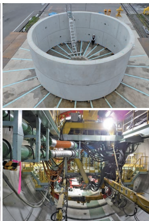
(上) 2m の幅があるセグメントの仮組状況 (下) 施工中の新横浜トンネル切羽部分
