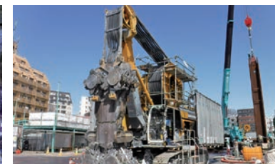
鋼製地中連続壁の掘削機
