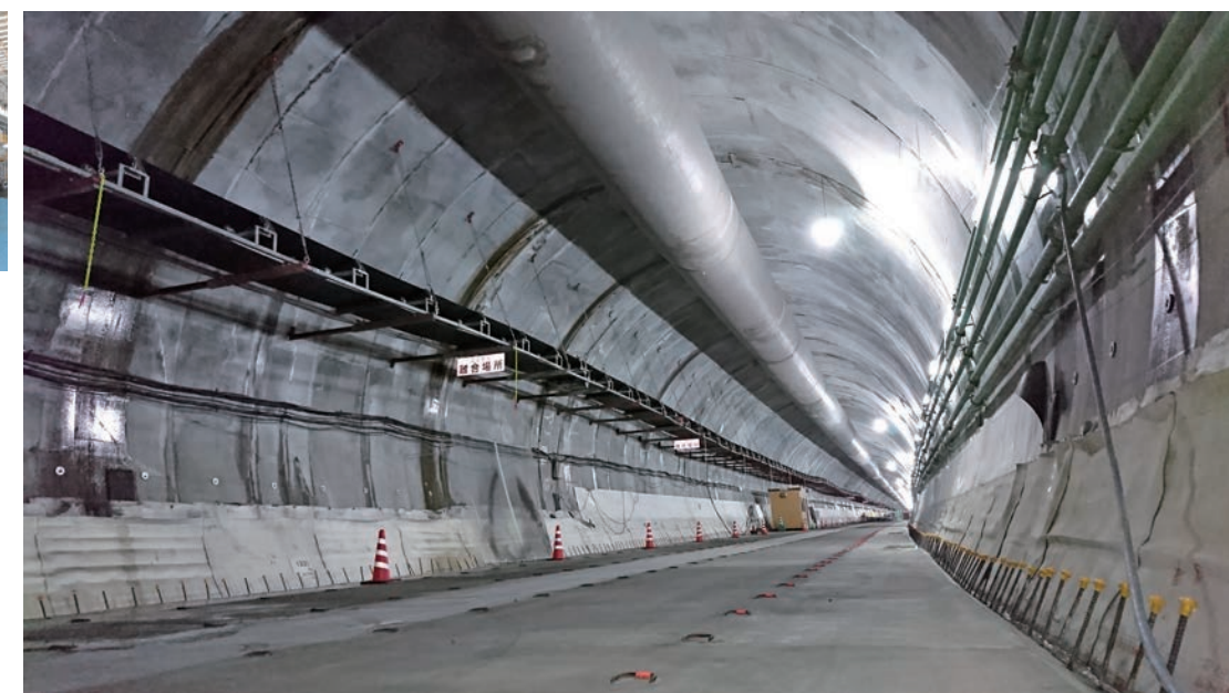
施工中の羽沢トンネル
