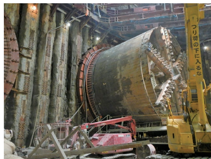
綱島トンネルを掘り進めるシールド機
