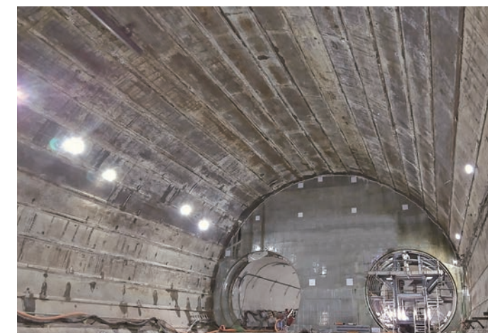
施工中の新綱島駅。広大な地下空間が現れた
