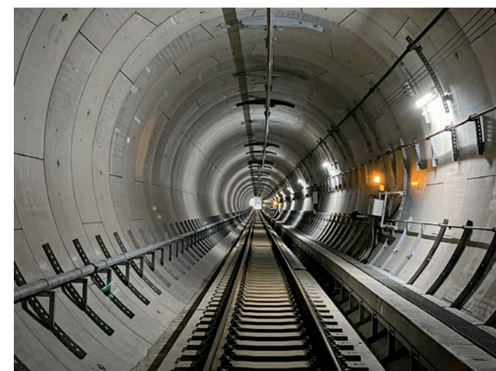
完成した綱島トンネル
