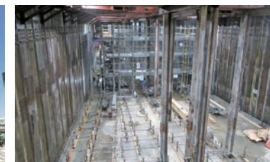
新横浜駅の鋼製地中連続壁
