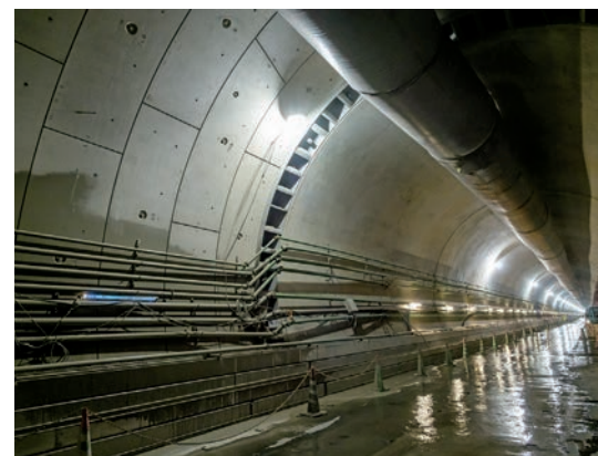
写真中央の継ぎ目を境に、手前がセグメントを使用した区間、奥がJRTT独自のSENSを使用した区間（2019年、羽沢トンネル）
