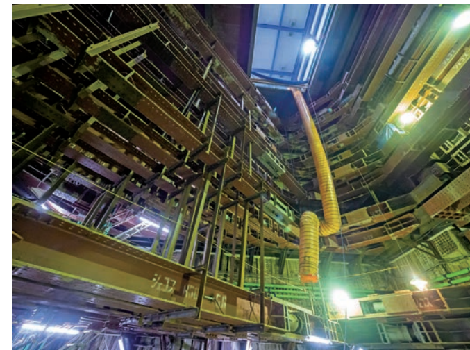
構造部材を建て込んで掘り進めていく（2018 年、新綱島駅）
