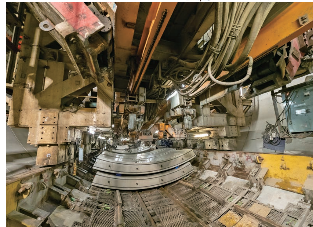
シールドマシン内で、掘削した壁面にセグメントを構築していく（2019年、羽沢トンネル）
