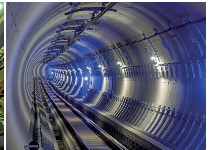
単線並列トンネルとして完成した綱島トンネル（西谷方面）
