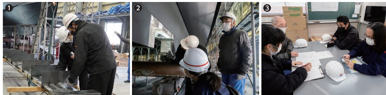
①溶接部を確認 ②水中翼接続部を確認 ③監督後の打ち合わせの様子
