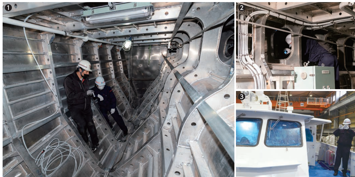
①②③船底部・船体を確認
