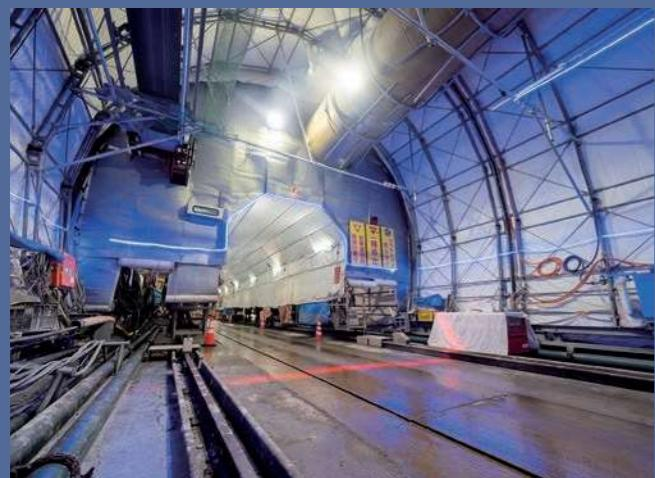
給水養生システム作業台と覆工セントル
