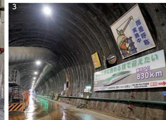
います。トンネル下部にも補強鋼材を入れて、トンネル断面の変形を抑える対策を講じています」(山口所長)
