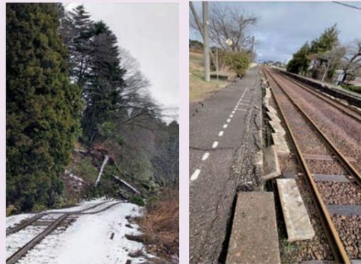
のと鉄道沿線は震源地に近いこともあり、被害は甚大だった。線路の曲がりや切断、土砂流入、駅施設の損壊などの被害が確認された。(写真提供：のと鉄道)
