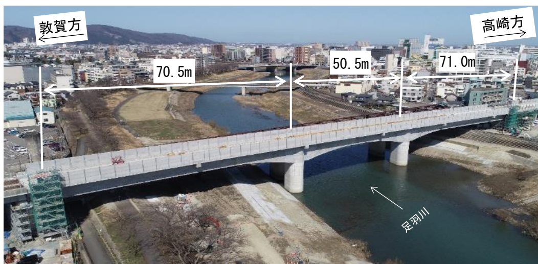
足羽川橋梁の施工状況
