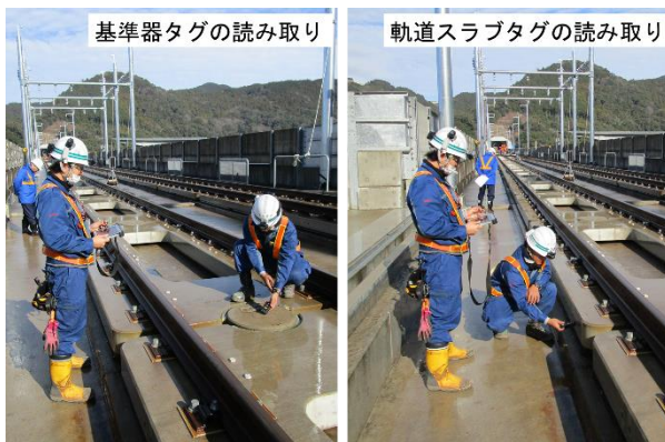
基準器・軌道スラブの電子情報読み取り状
