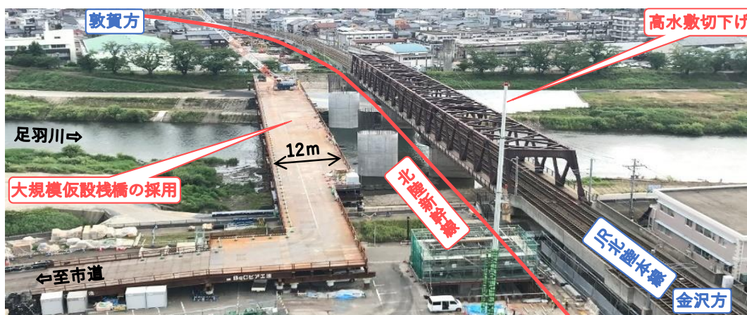
大規模仮設栈橋を使用した施工状況
