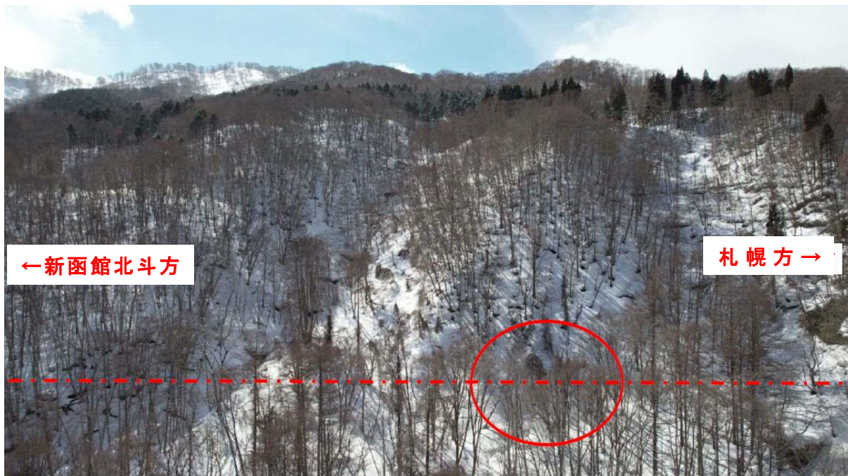
トンネル坑内土砂流入箇所の直上の地表状況 (令和4年3月21日(月)午後1時頃撮影)
