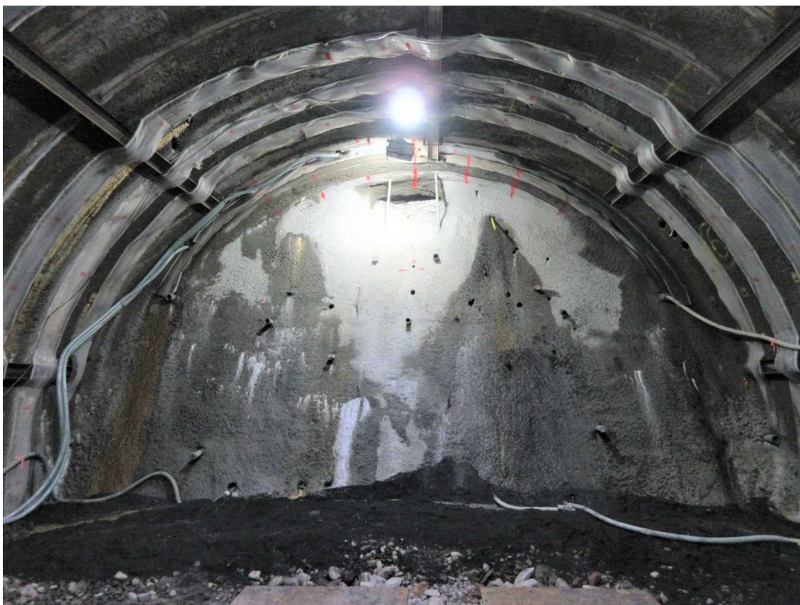
坑内の土砂流入防止措置完了の状況（令和4年5月10日午前8時30分頃撮影）
