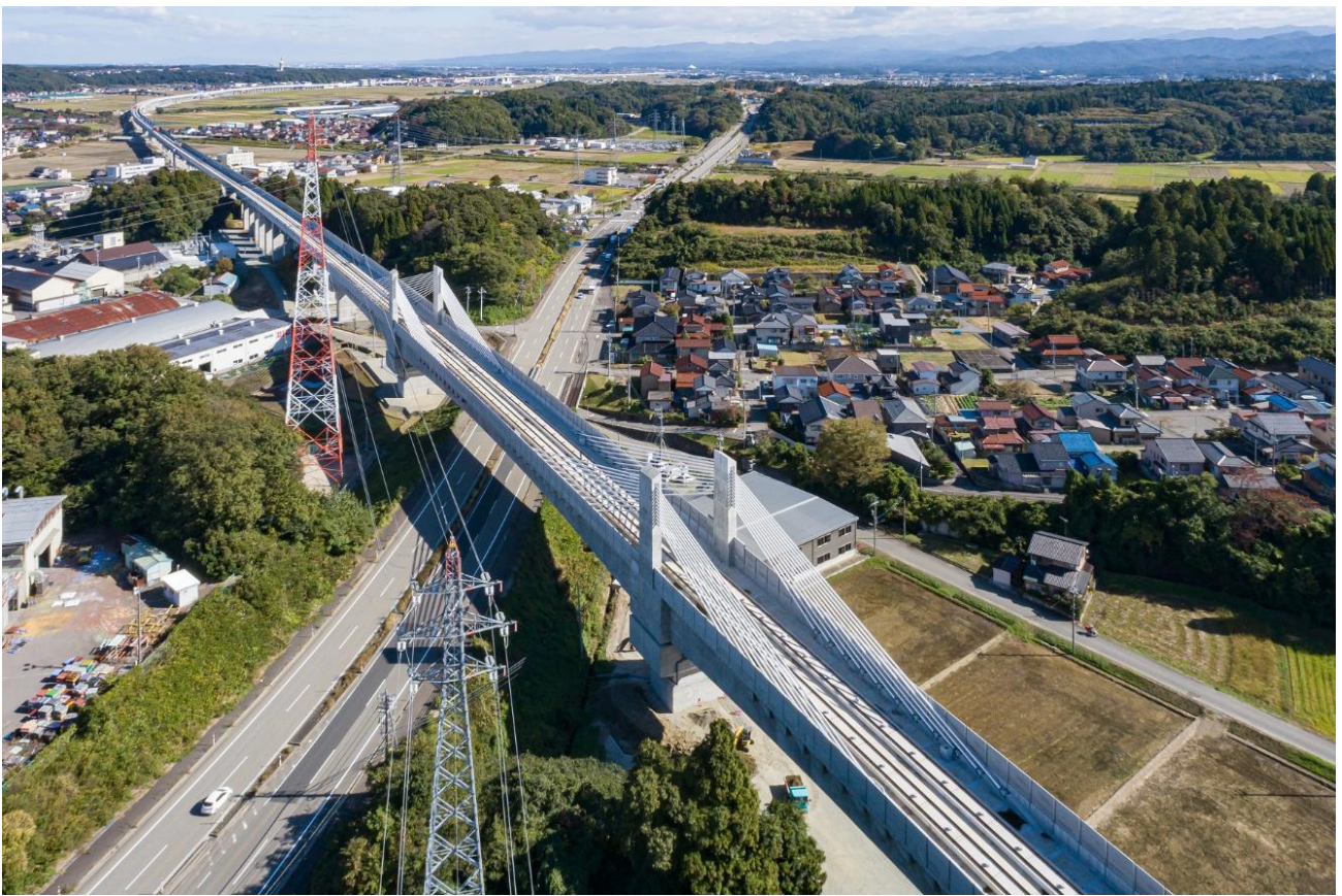
完成状況全景(国道8号福井方より空撮)
