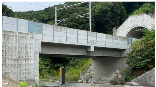
初採用となる PC 桁を用いた GRS 一体橋梁 (L=30m)
