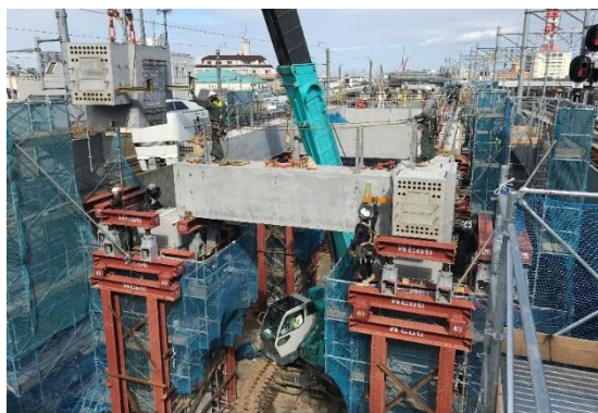
プレキャスト部材組立状況
