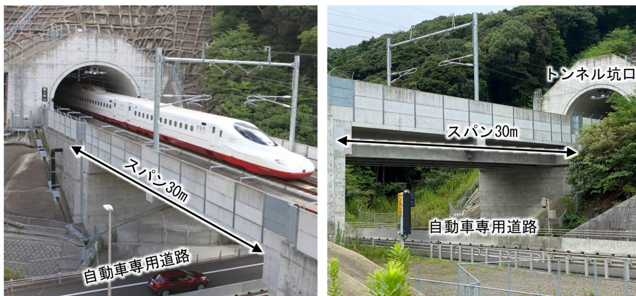
図1 原種架道橋（西九州新幹線 諫早駅～長崎駅間）にて実用化
