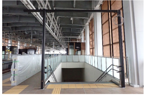
ホーム階の階段と木調の日除け
