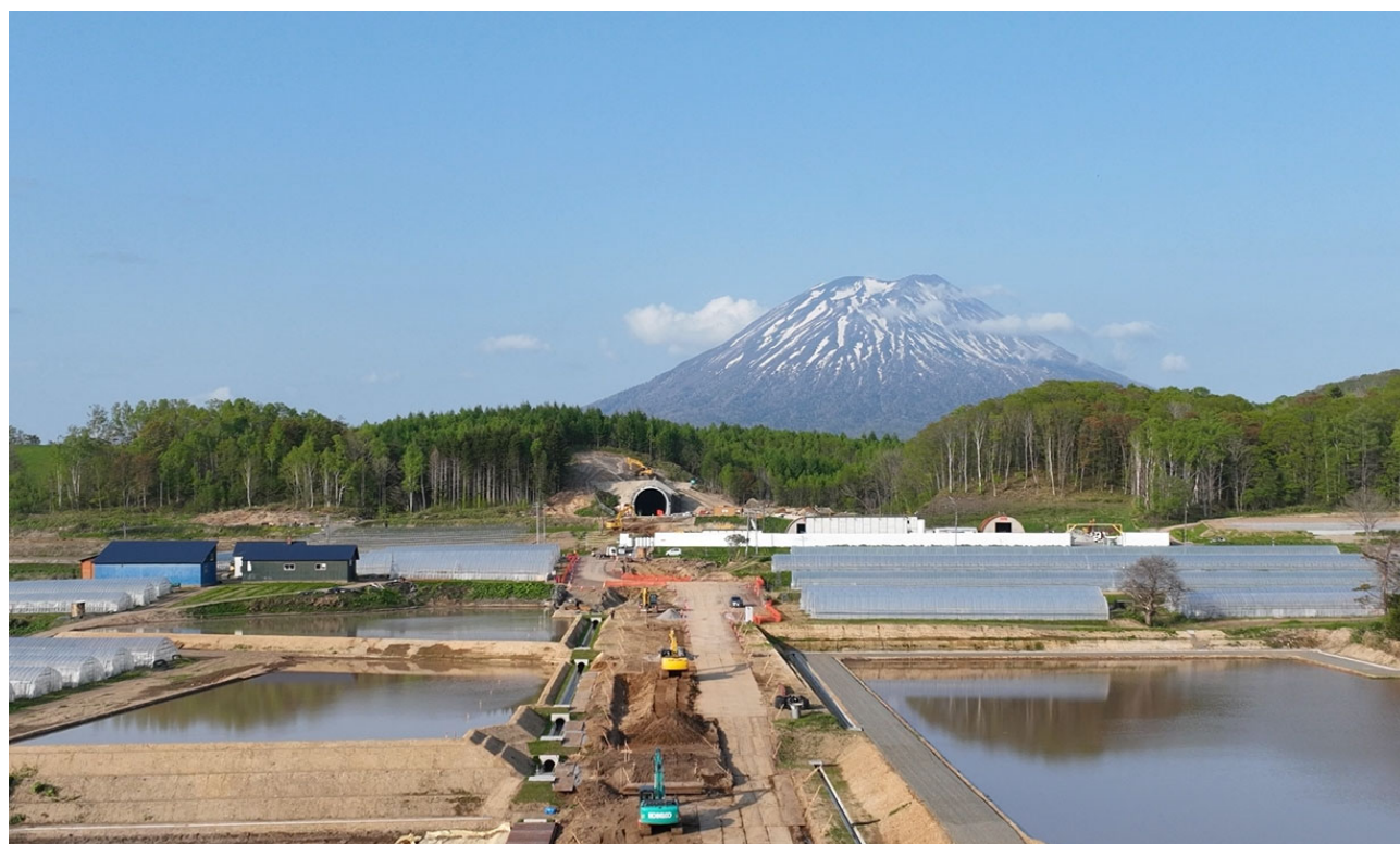
【現在の工区内の写真（ニセコ町宮田：札幌方を望む）】
