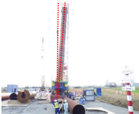
斜杭基礎の施工状況
