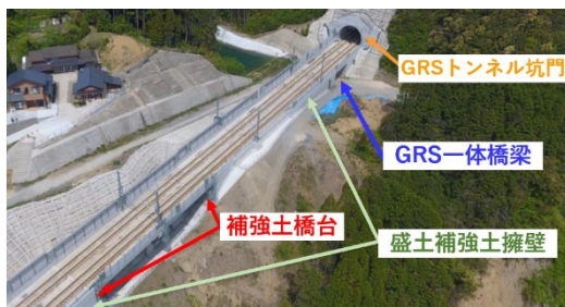
GRS 構造物の積極的な採用 (九州新幹線、大山路高架橋他)
