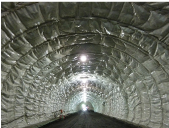
従来工法での施工状況
