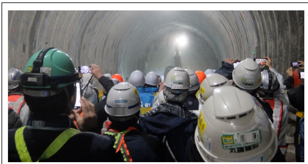
貫通の状況（撮影：令和7年4月8日）
