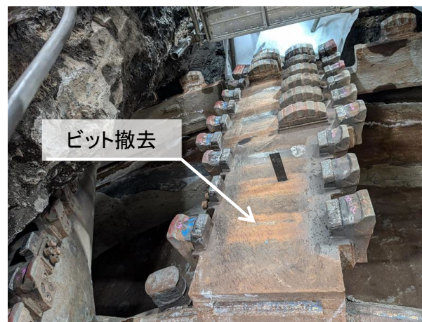
摩耗ビット撤去
