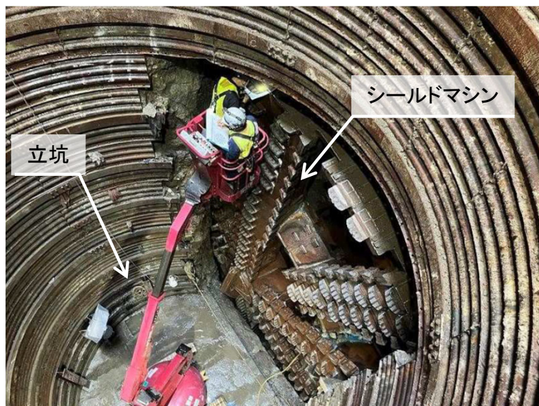
シールドマシンビット点検状況
