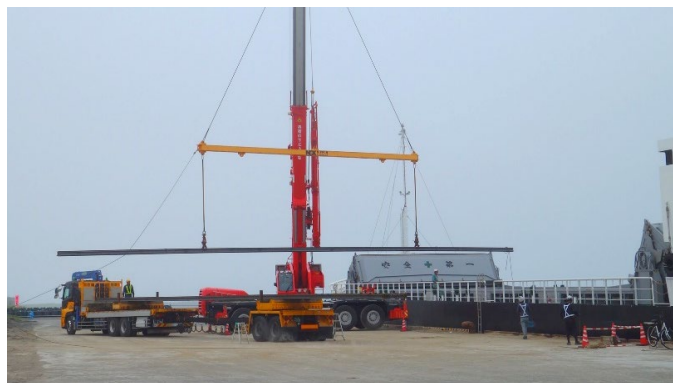
（イメージ）レール陸揚げ作業の様子
